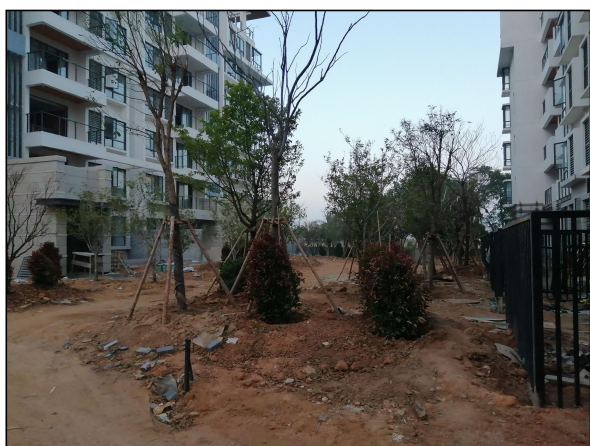
项目用地绿化施工（2021 年 10 月）
