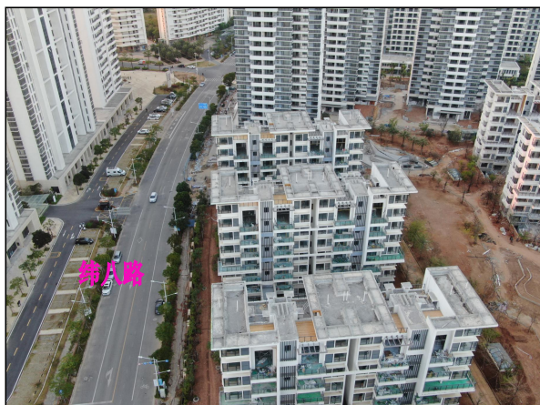
项目用地西面施工照片（2021 年 10 月）
