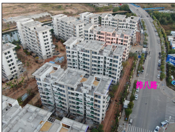
项目用地西南面施工照片（2021 年 10 月）
