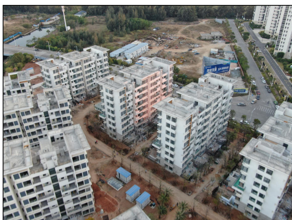
项目用地南面施工照片（2021 年 10 月）
