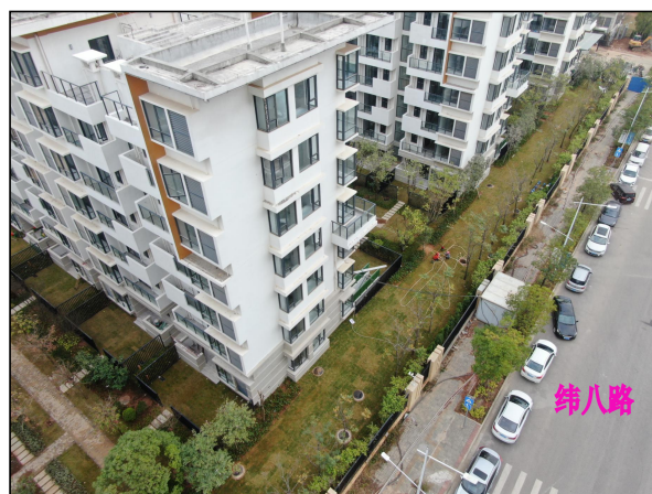
项目用地西南面现状（2021 年 12 月）
