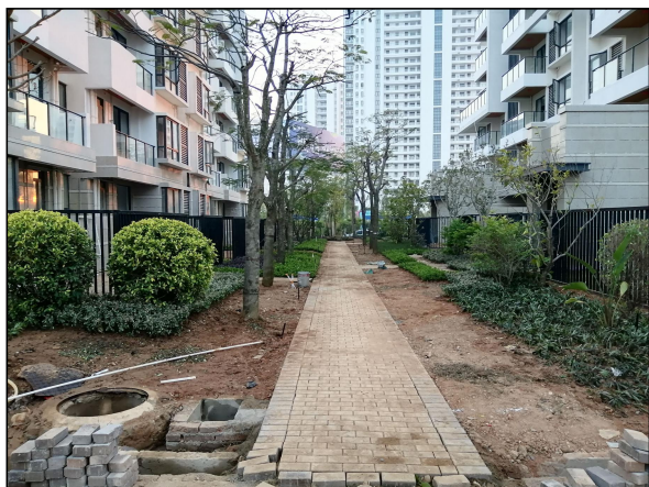
项目用地人行道铺砖及绿化施工（2021 年 10 月）
