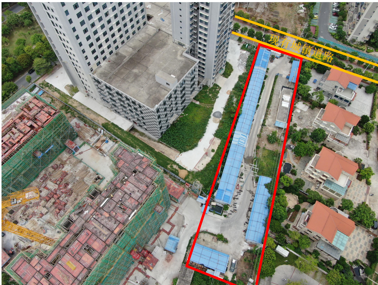
施工生产生活区布设区域现状图
