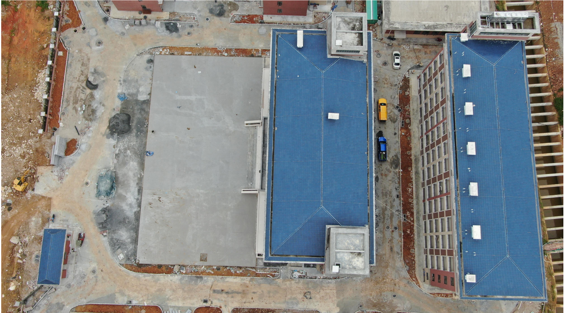
图 4 综合楼及教师房施工现状图
