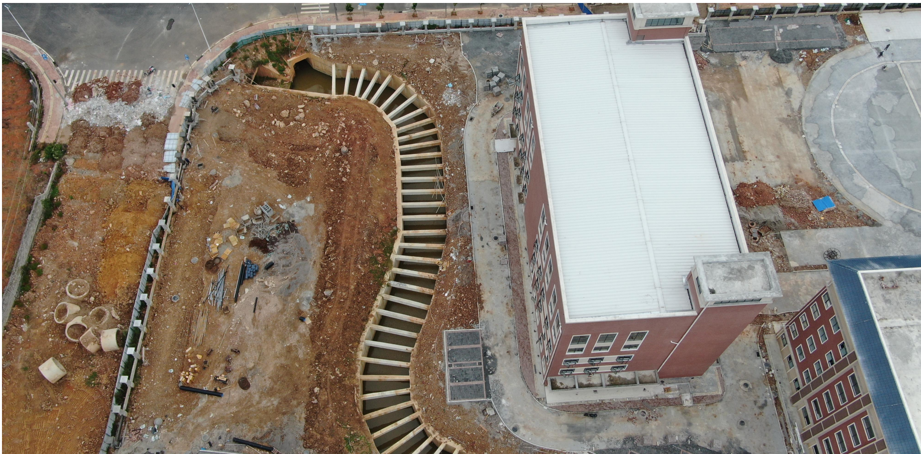
图 8 主体工程区道路及堆渣现状图
