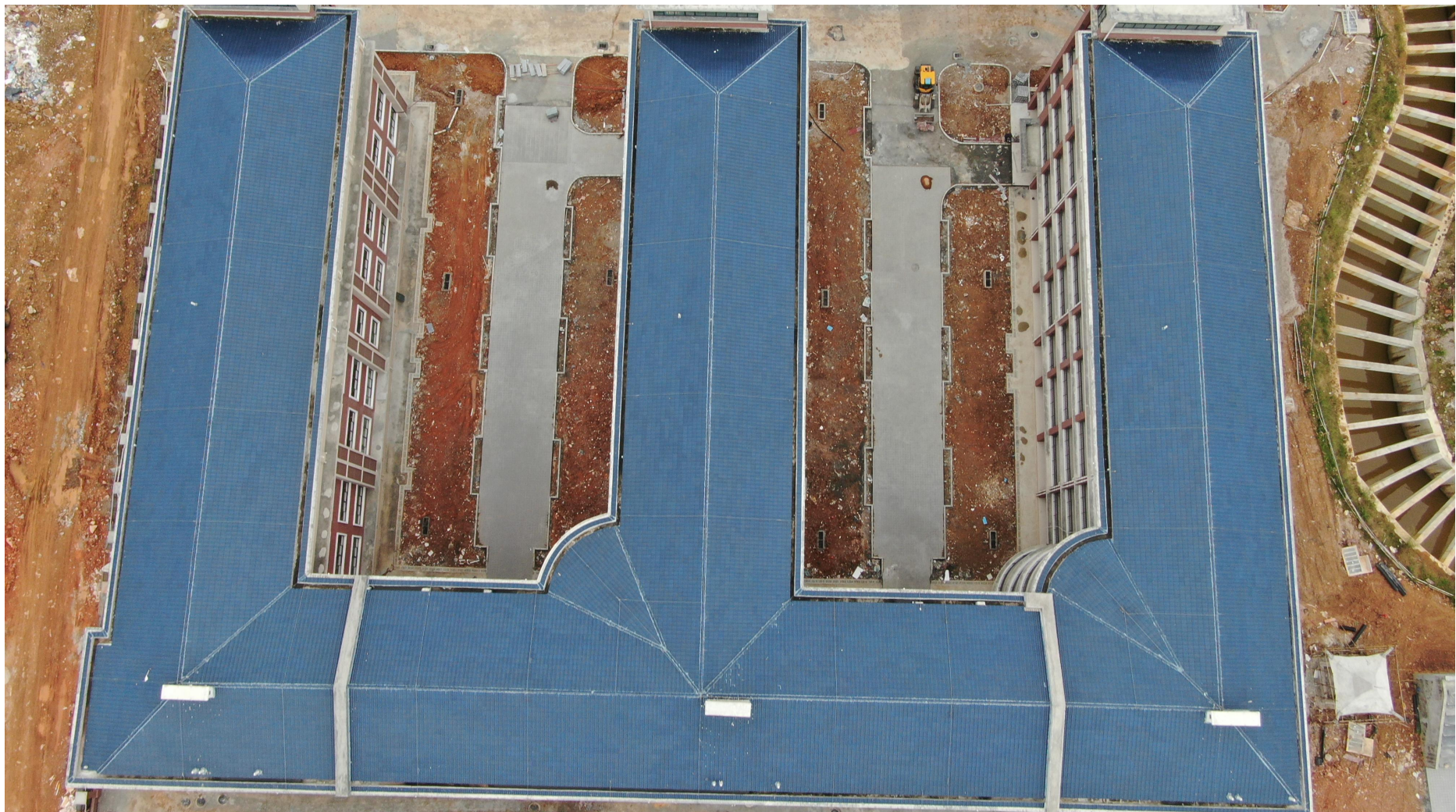
图 3 1#-3#教学楼施工现状图
