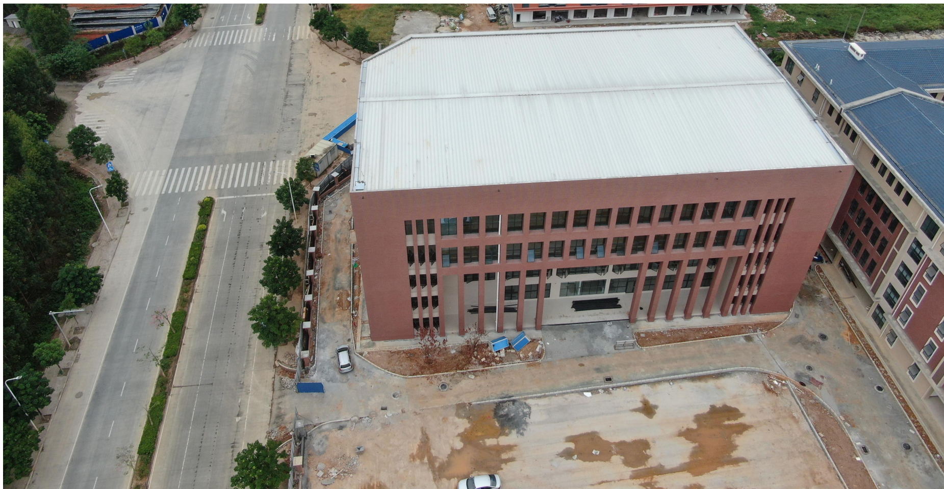
图 1 食堂施工现状图
