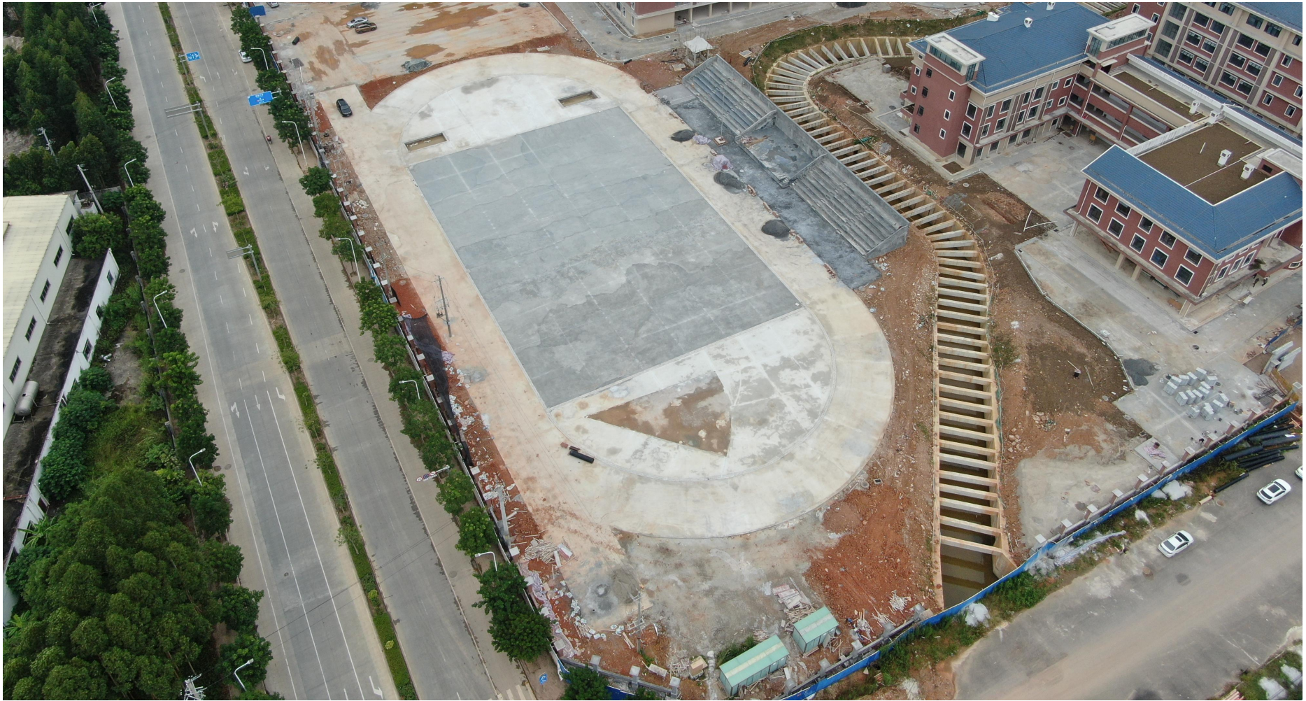
图 6 施工生产生活区及体育场施工现状图
