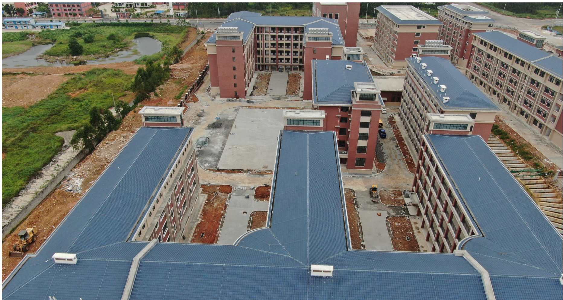
图2 教学楼、综合楼及学生宿舍施工现状图
