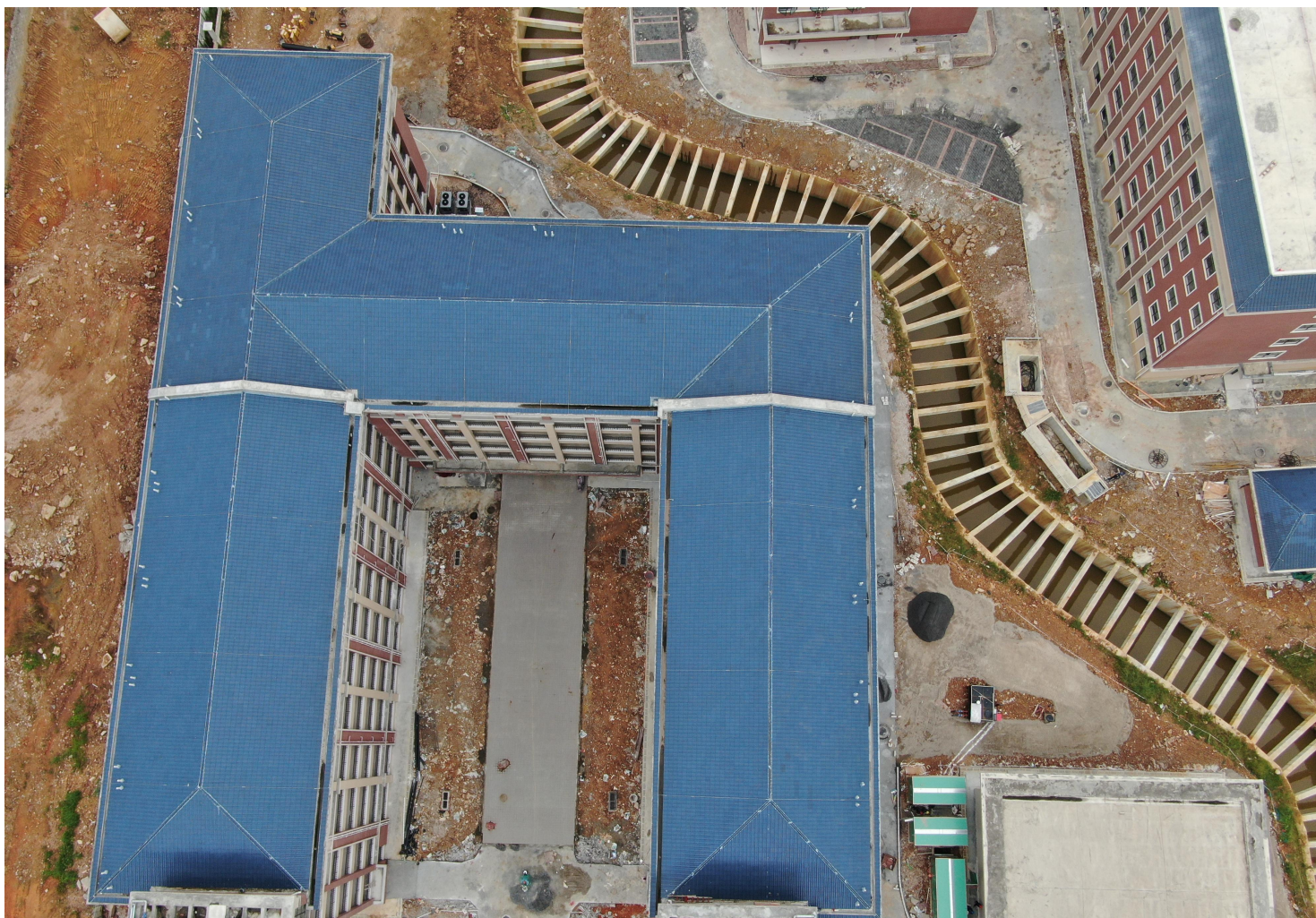
图 5 1#-2#学生宿舍施工现状图
