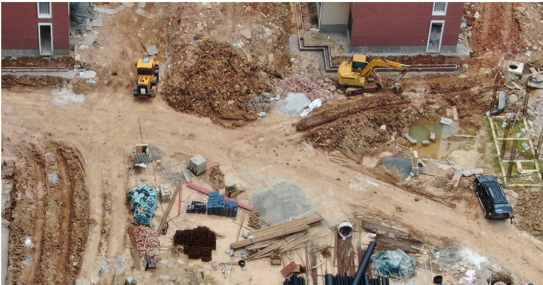
图 8 主体工程区道路及堆渣现状图
