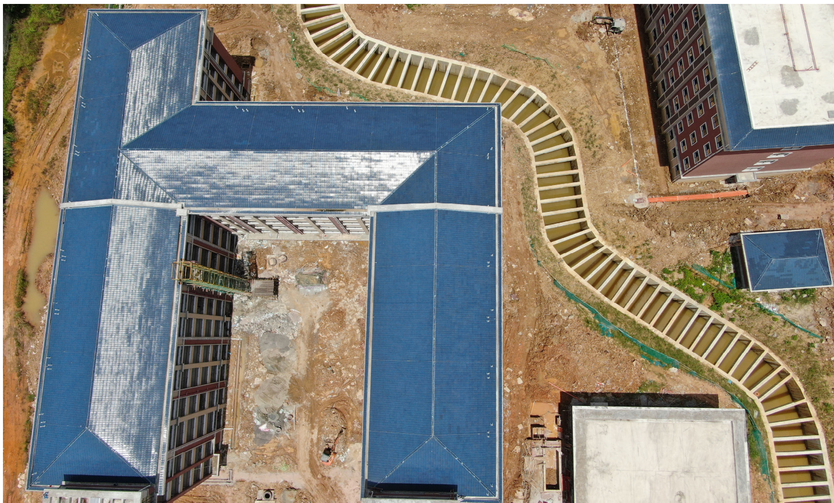
图 5 1#-2#学生宿舍施工现状图
