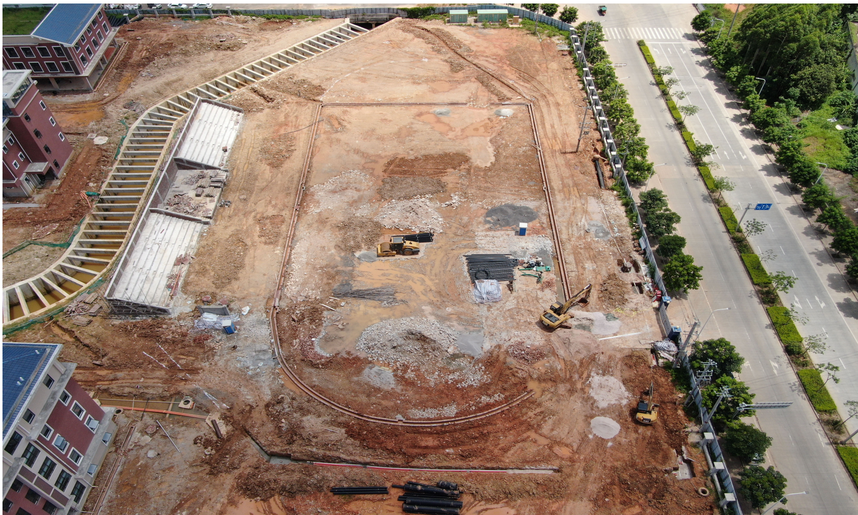
图 6 施工生产生活区及体育场施工现状图
