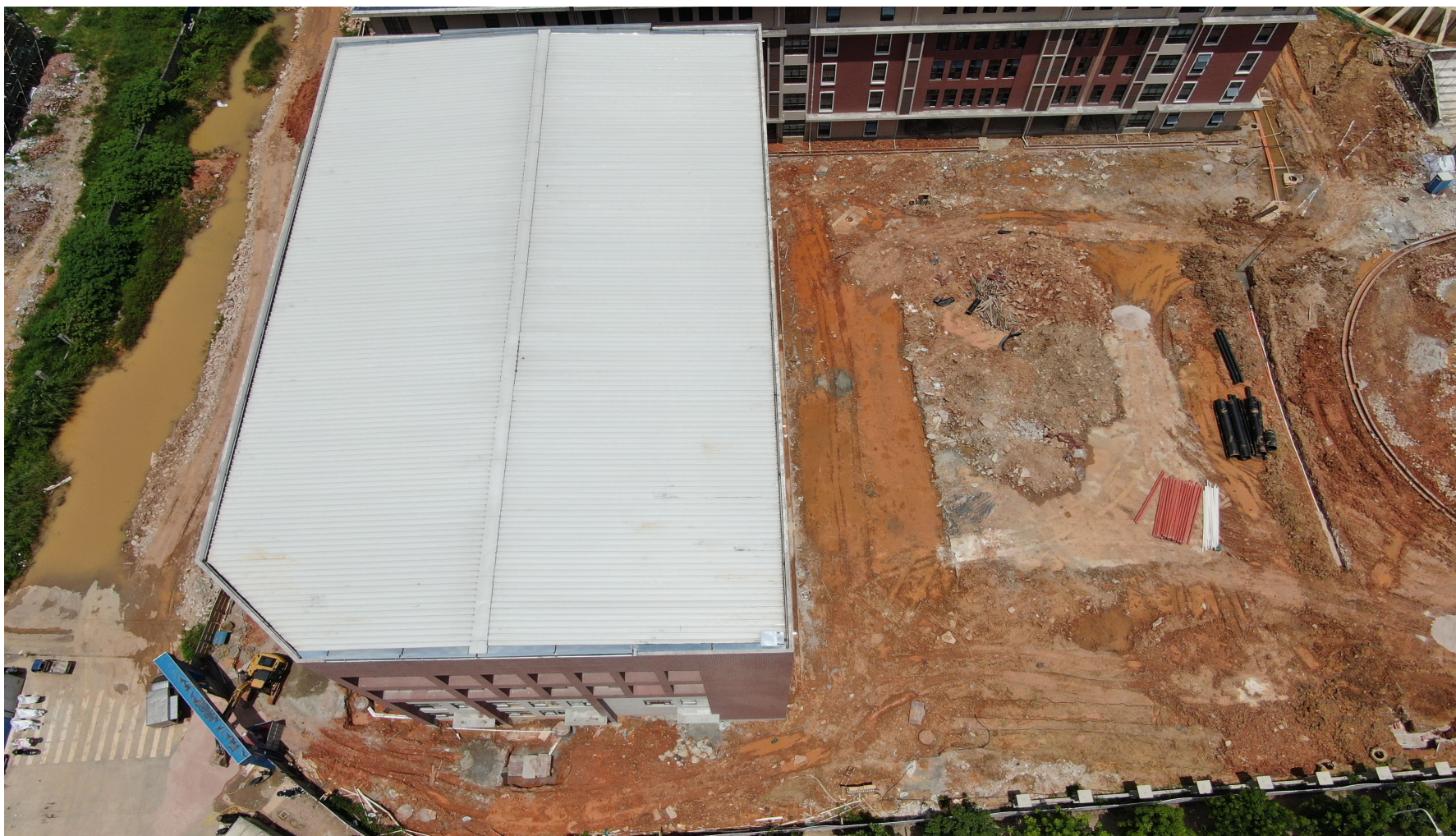
图 1 食堂施工现状图
