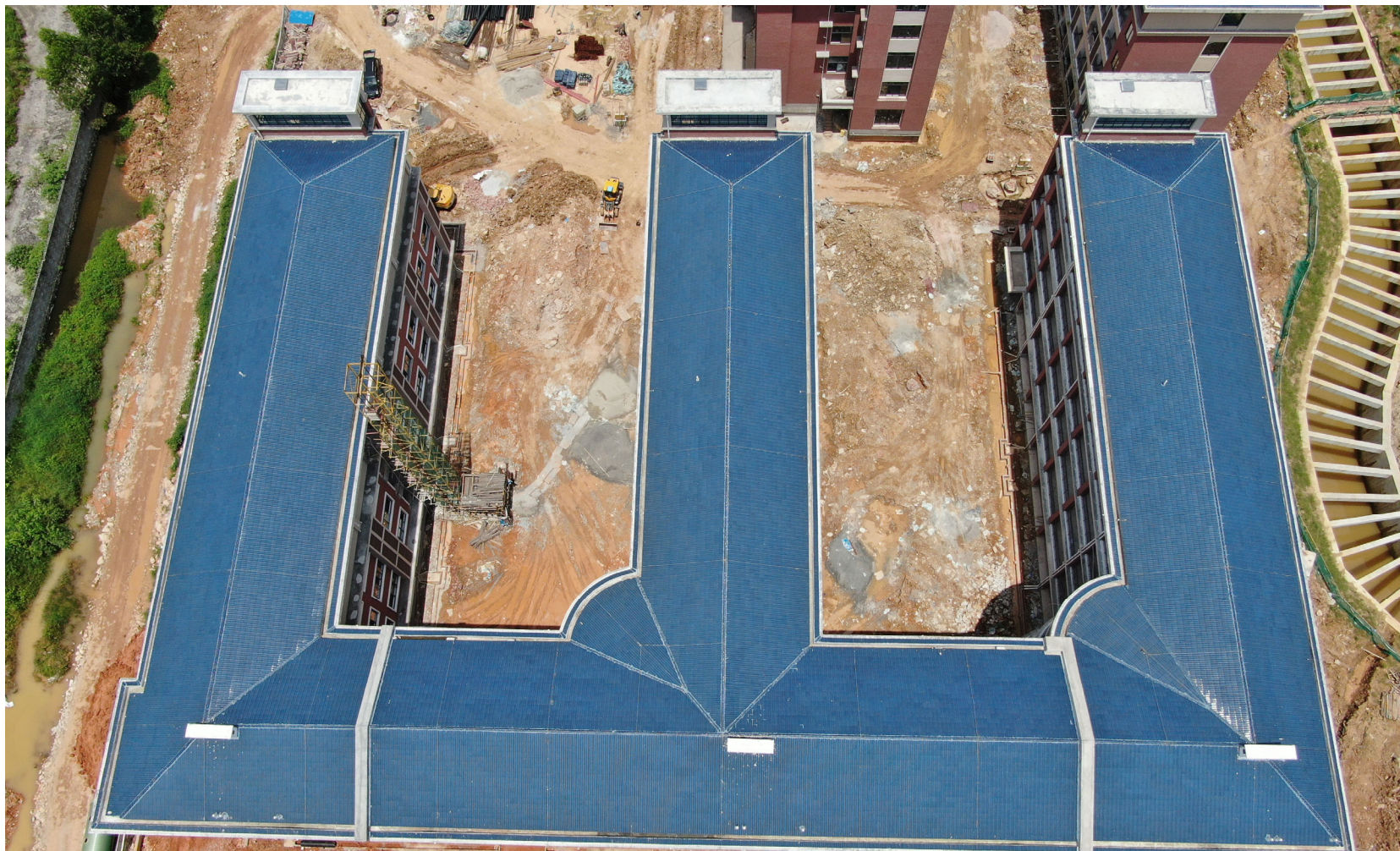
图 3 1#-3#教学楼施工现状图
