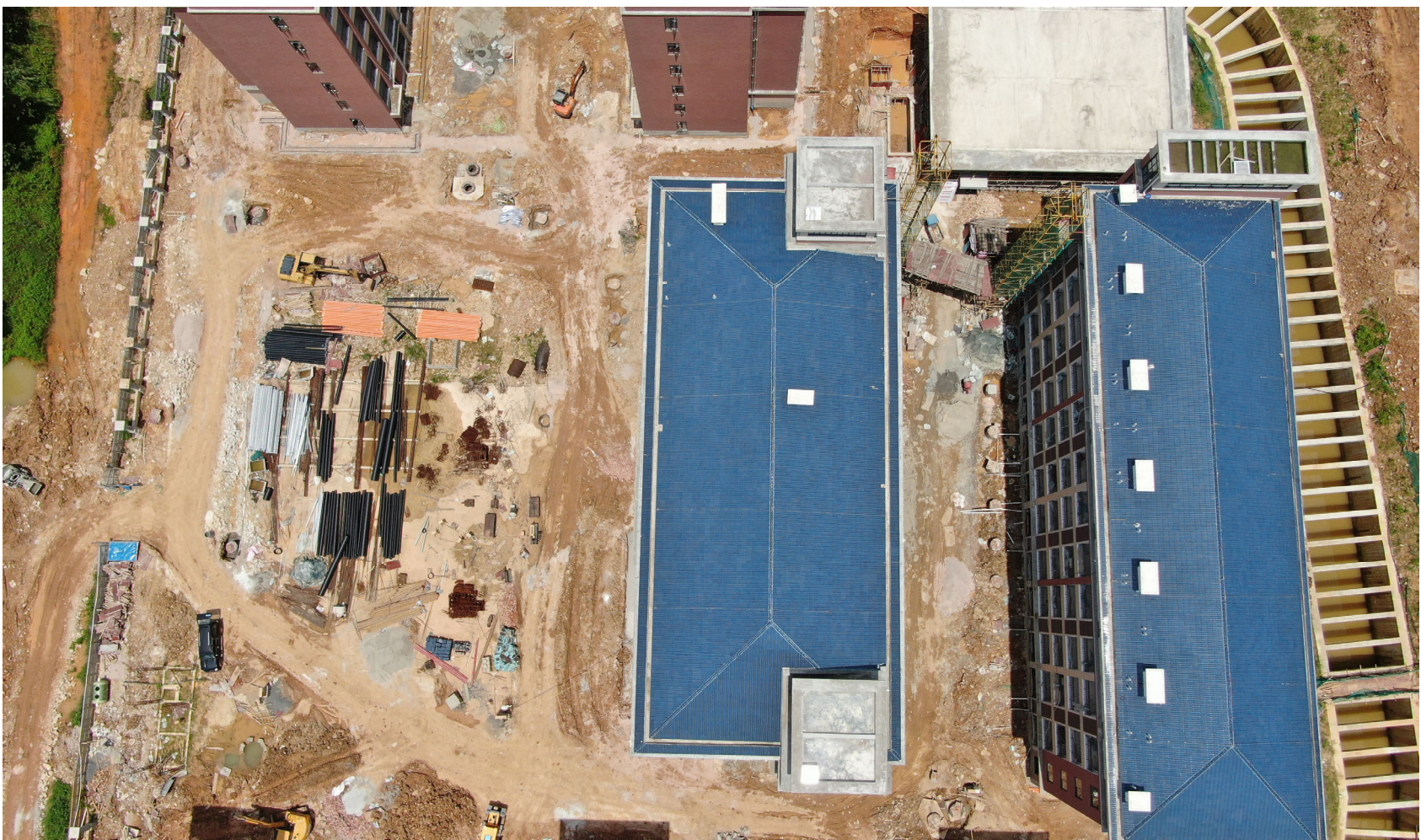
图 4 综合楼及教师房施工现状图
