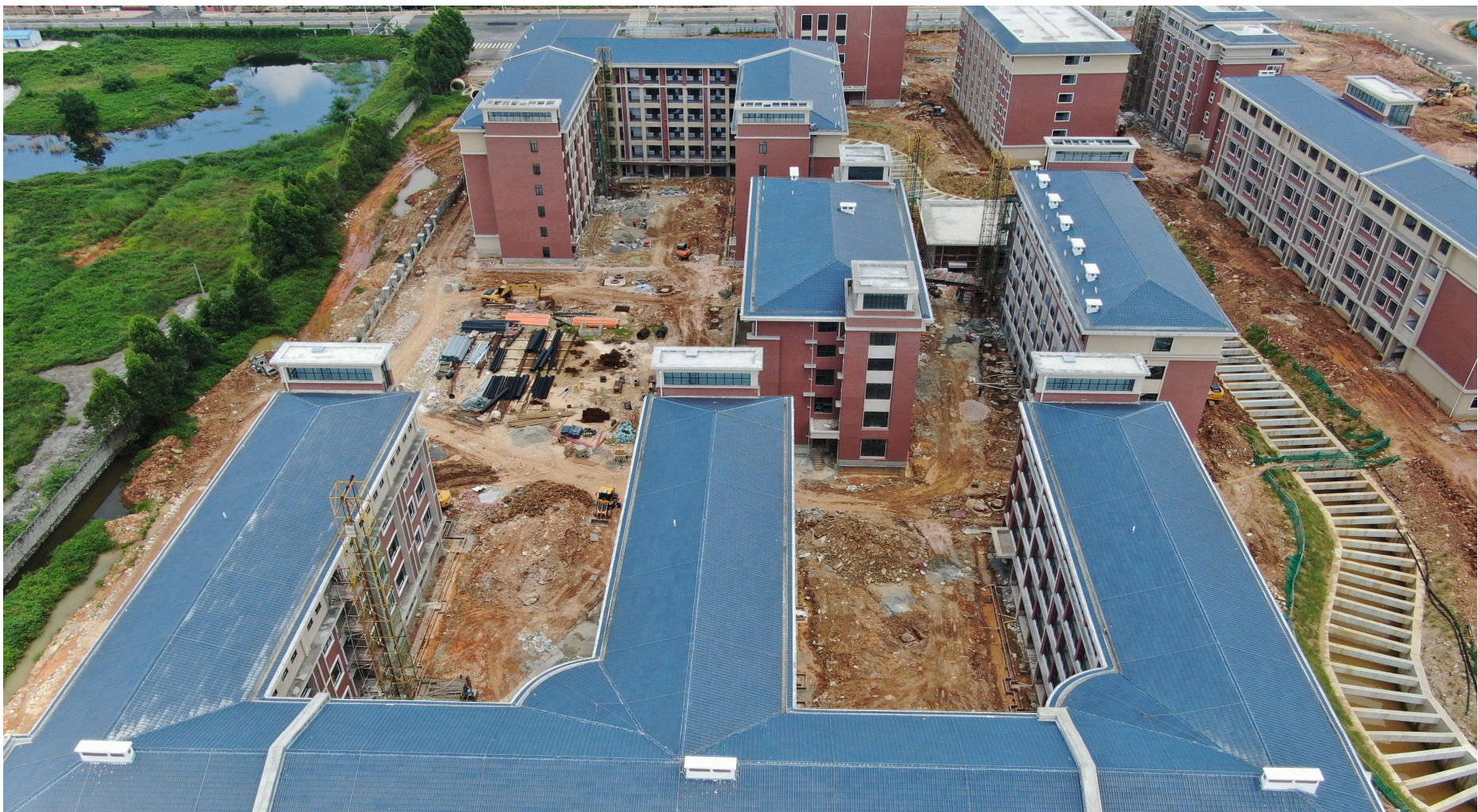
图2 教学楼、综合楼及学生宿舍施工现状图
