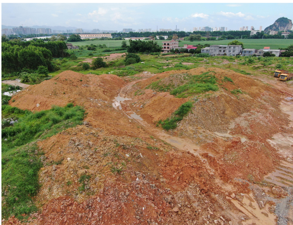
沟槽开挖附近堆土现状，无拦挡、排水、沉沙、苫盖防护措施
