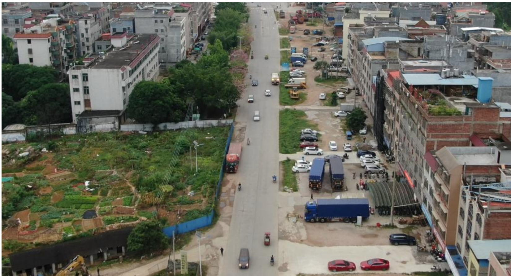
B3+079 段附近管网施工现状图
