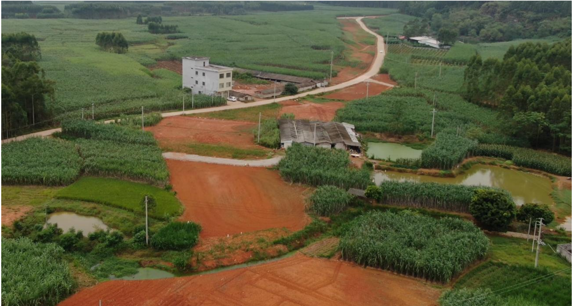
K1+860 段附近管网施工现状图
