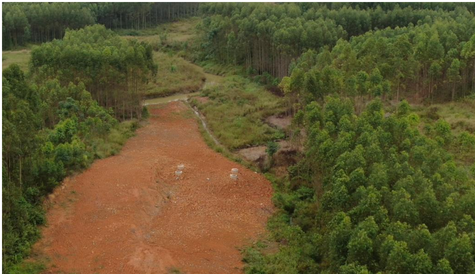
K5+380 段附近管网施工现状图
