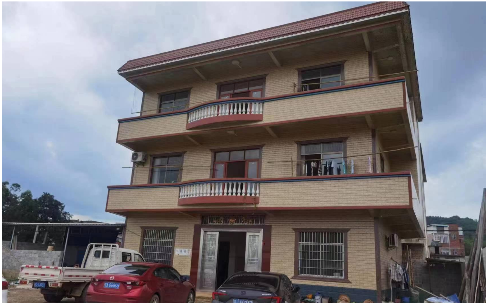
施工生活区租用房屋现状图
