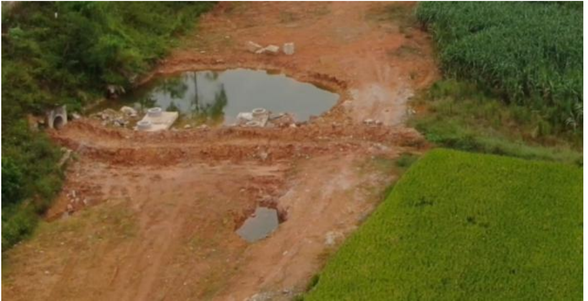
检查井雨后积水现状图
