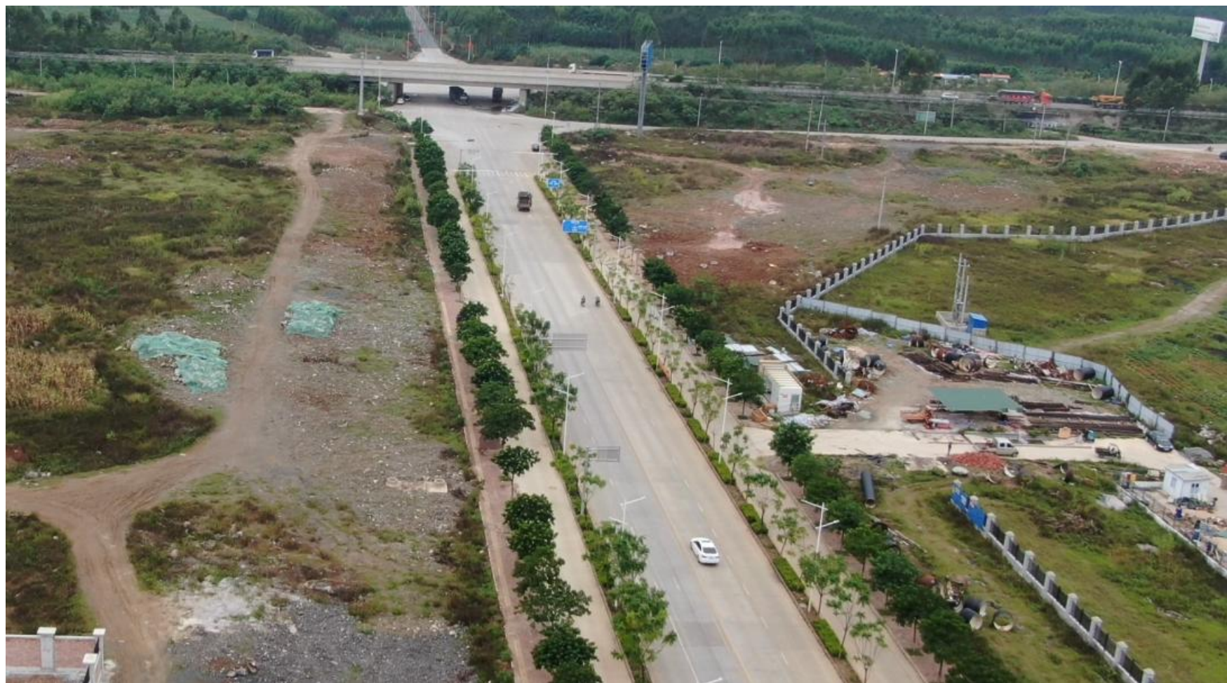
进港五路与汽车大道施工现状图
