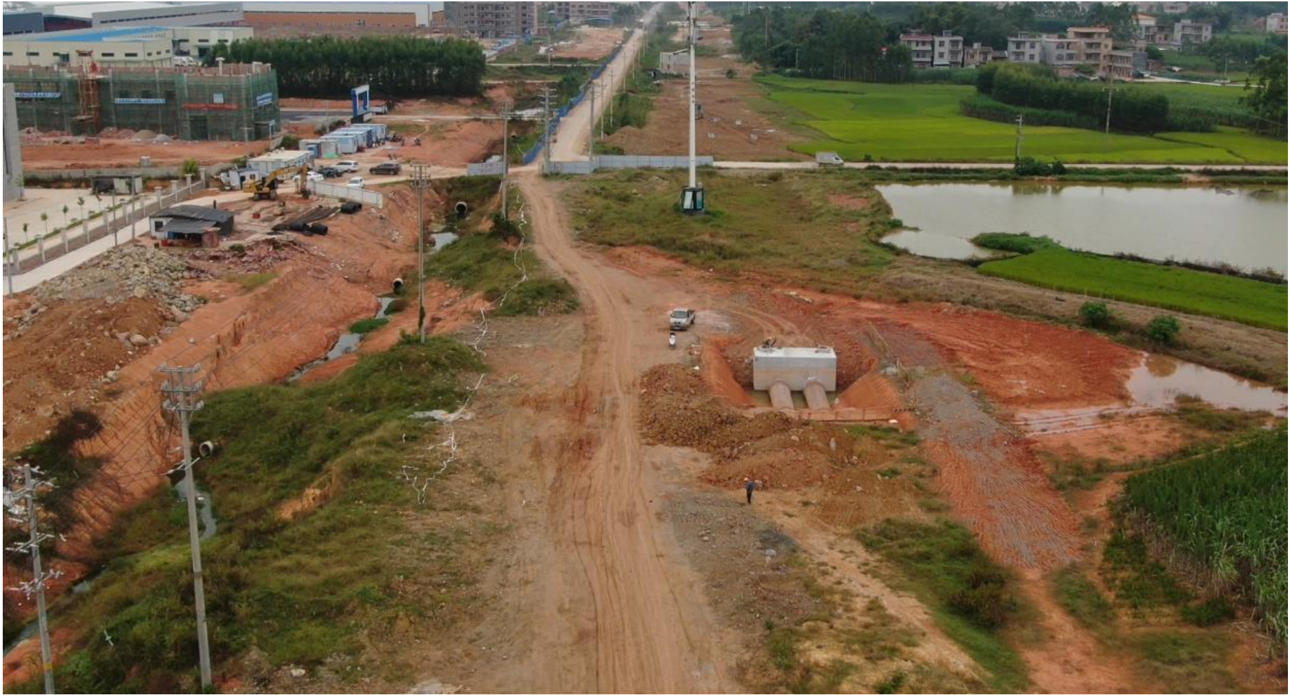
K7+260 段附近管网施工现状图
