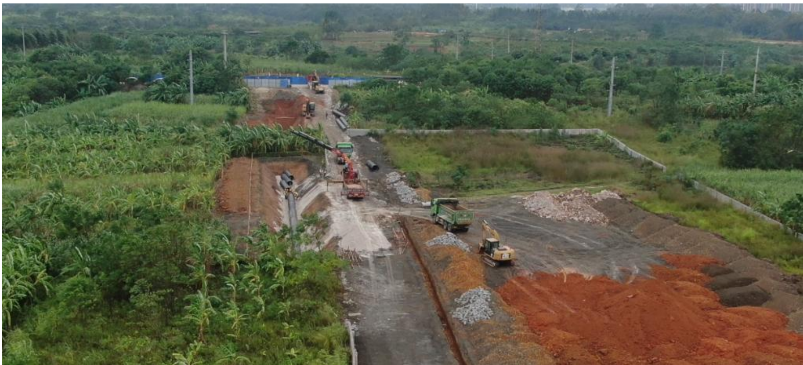
B0+780 段附近管网施工现状图
