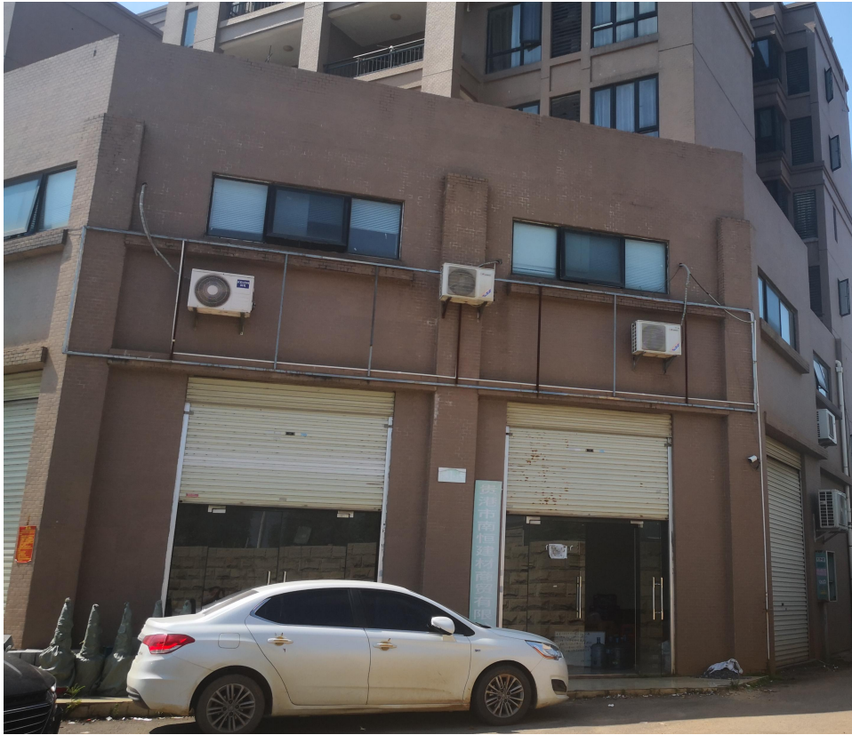
施工生活区租用房屋现状图
