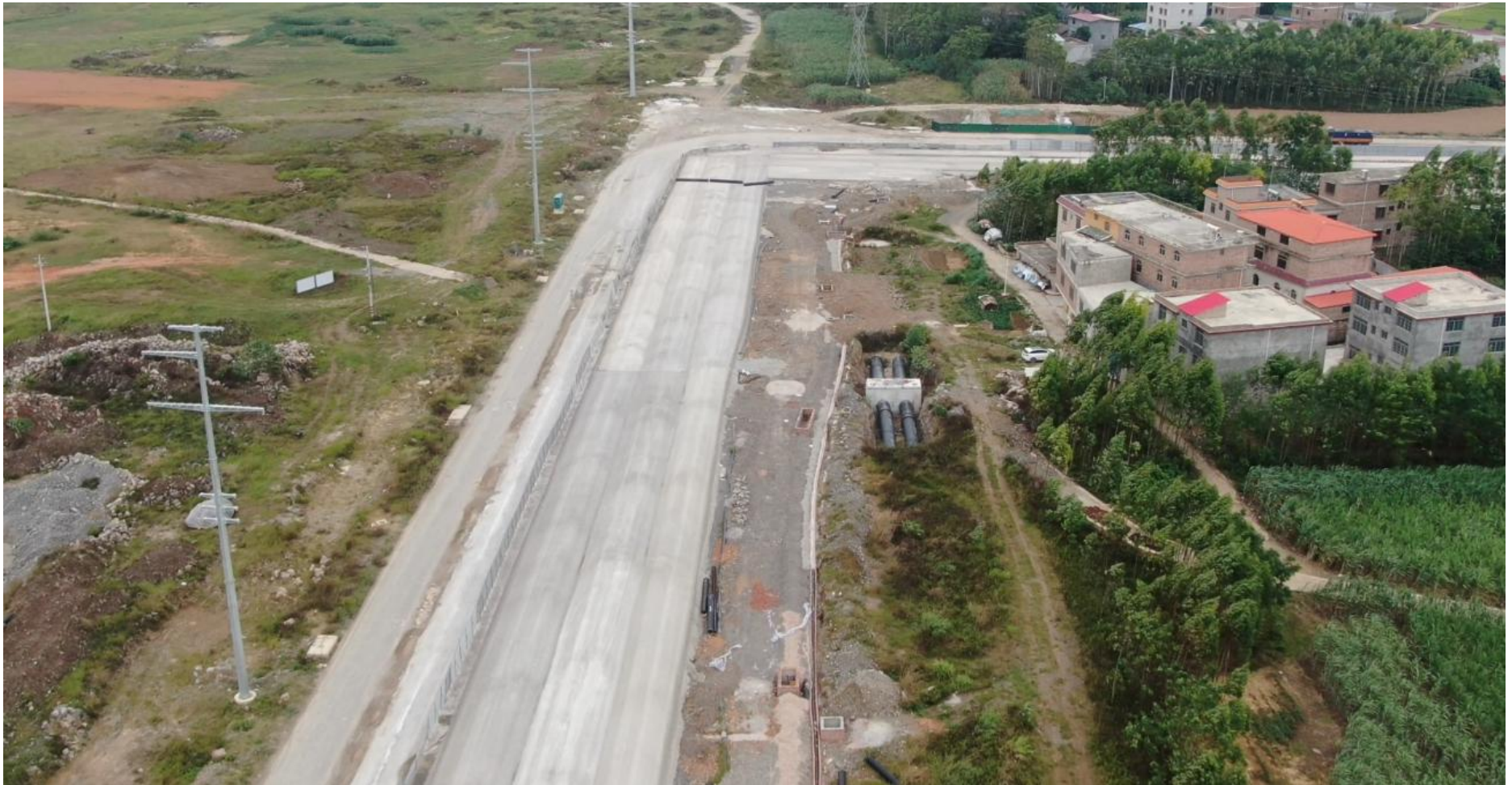
K9+580 段附近管网施工现状图
