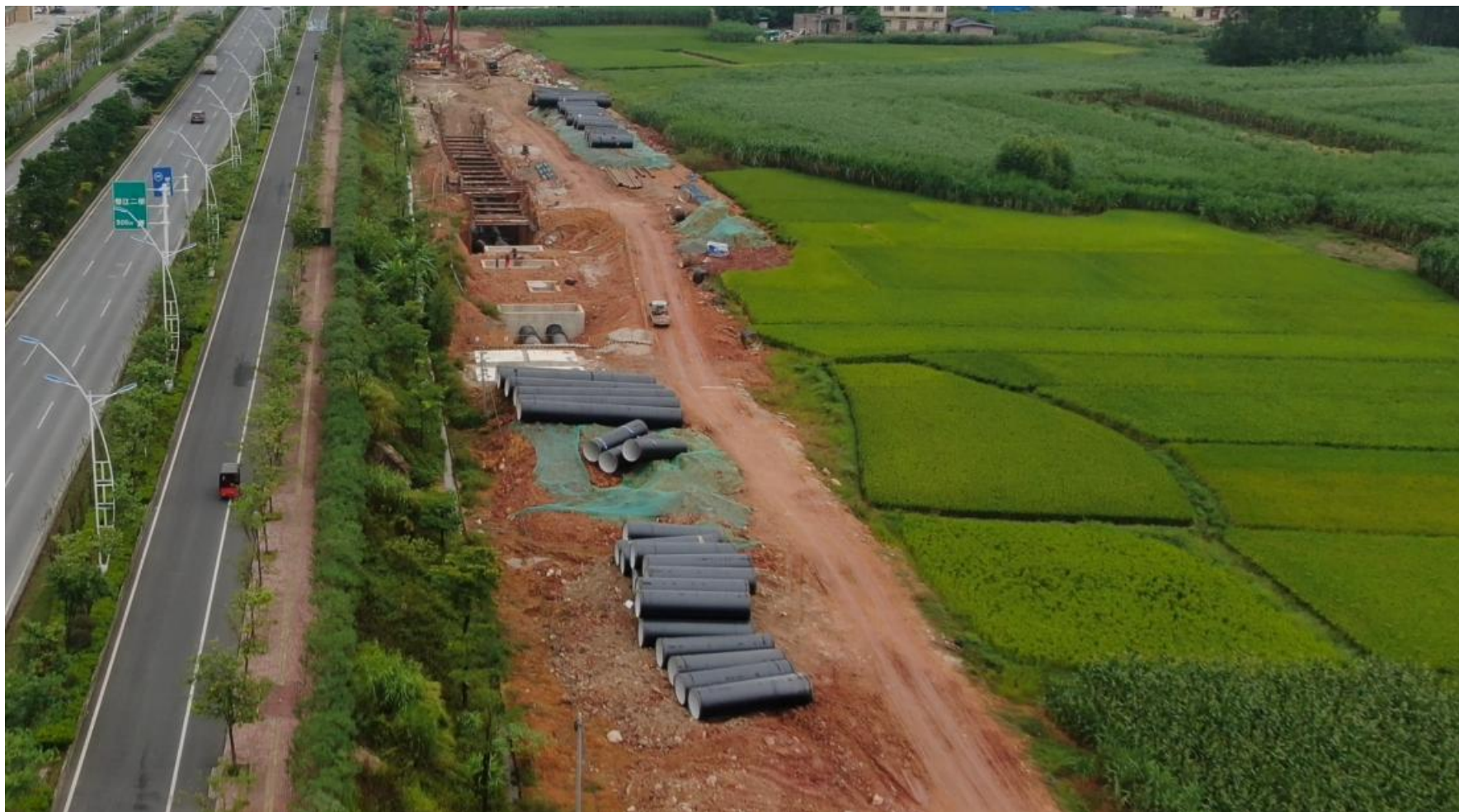
K17+180 段附近管网施工现状图
