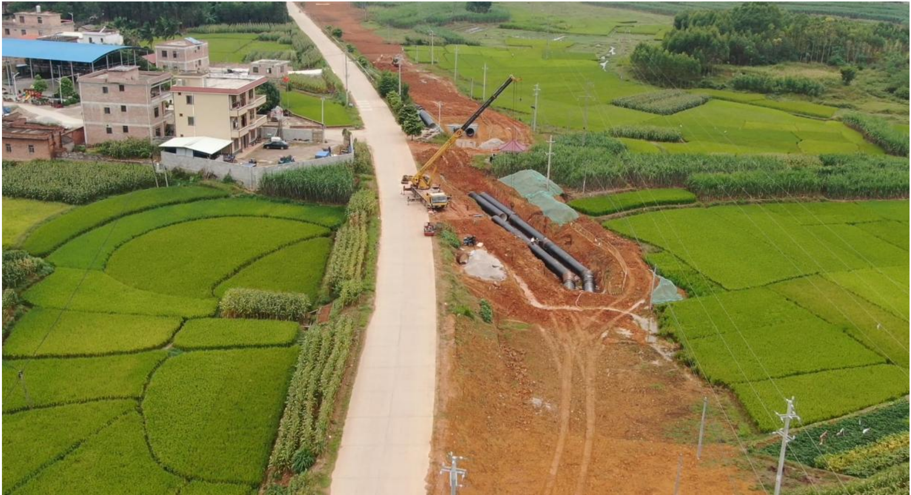
K3+760 段附近管网施工现状图
