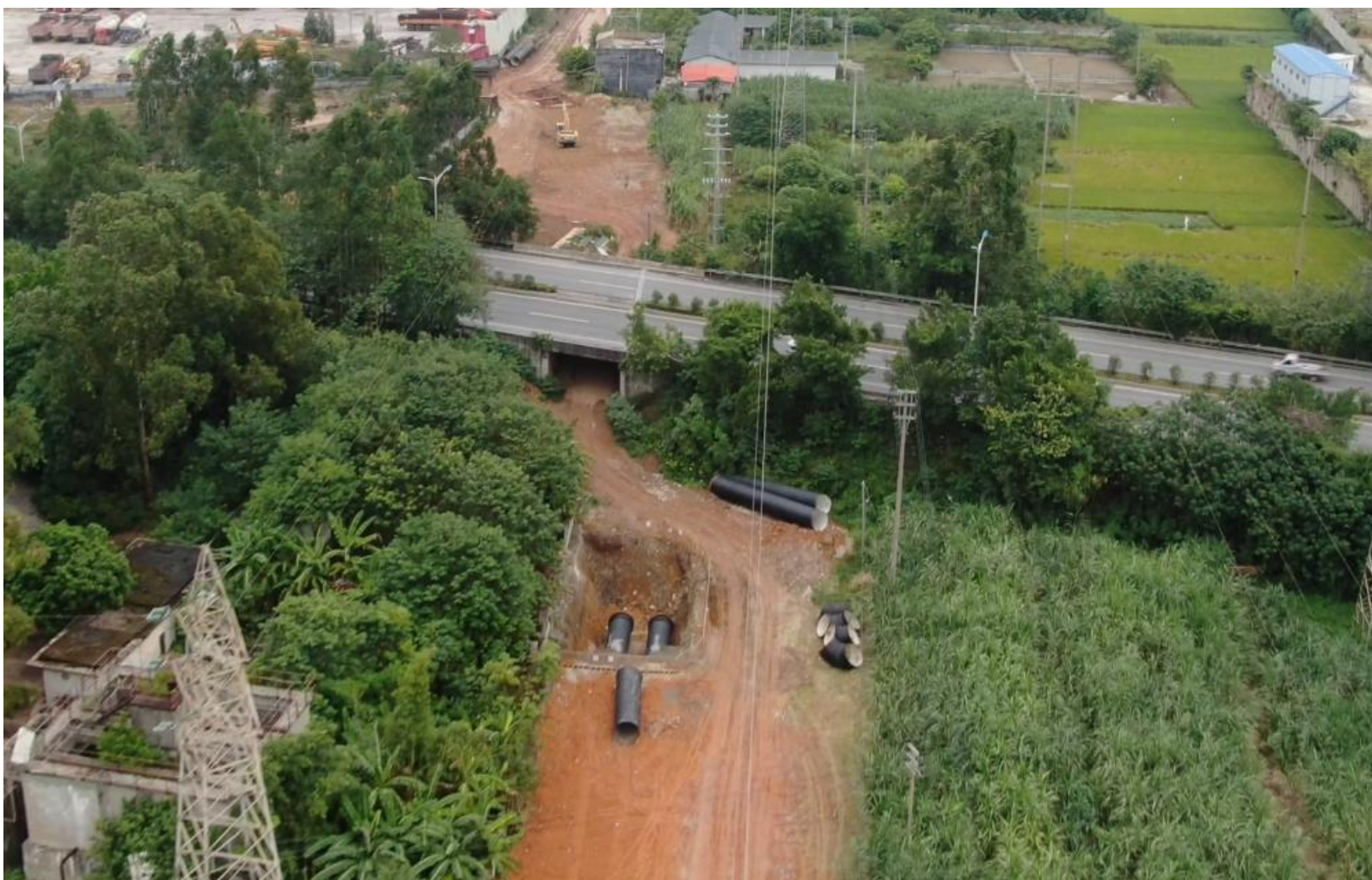
K23+140 段附近管网施工现状图
