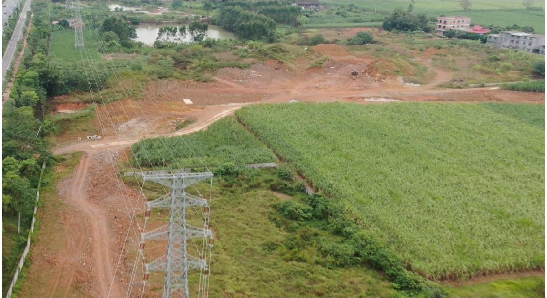
汽车大道与七星山北三路施工现状图
