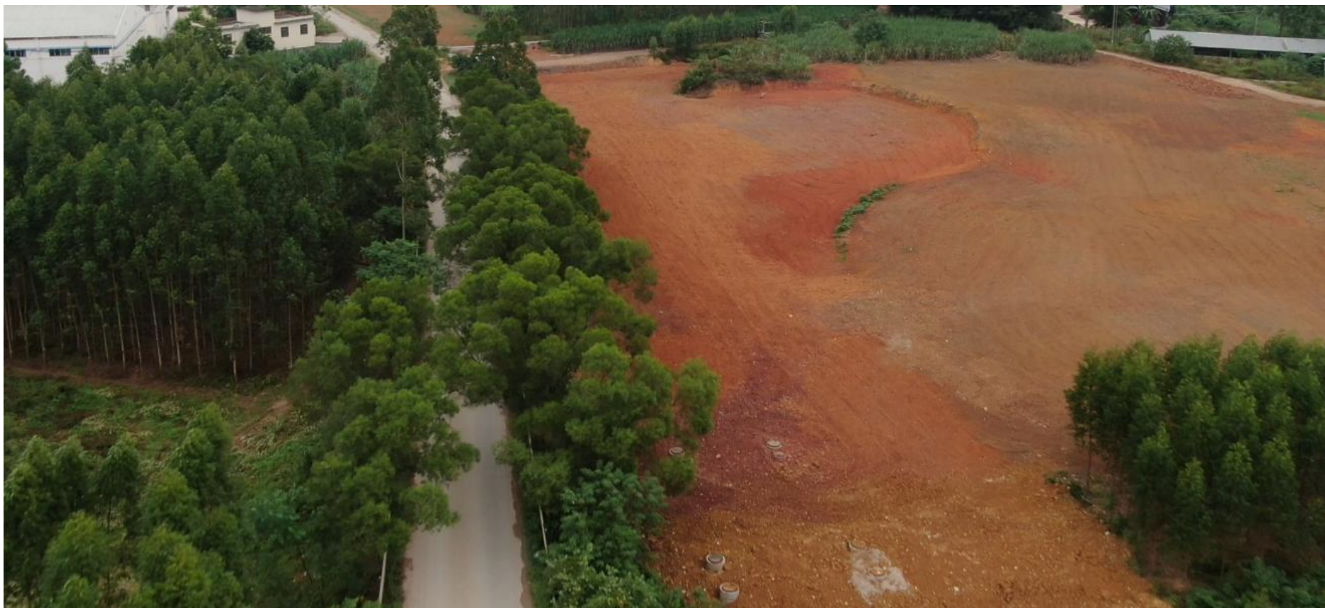
K15+940 段附近管网施工现状图
