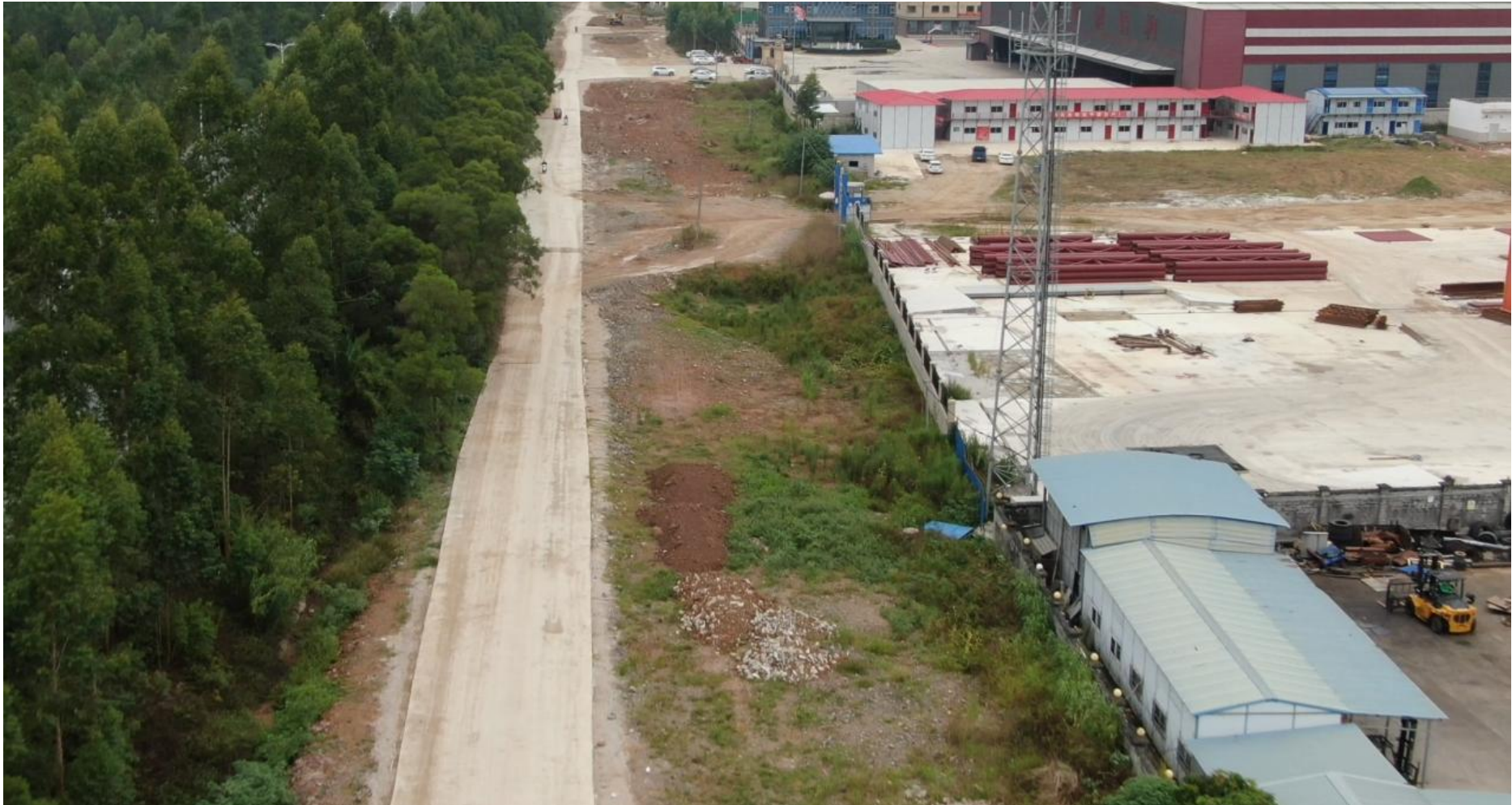
K14+000 段附近管网施工现状图
