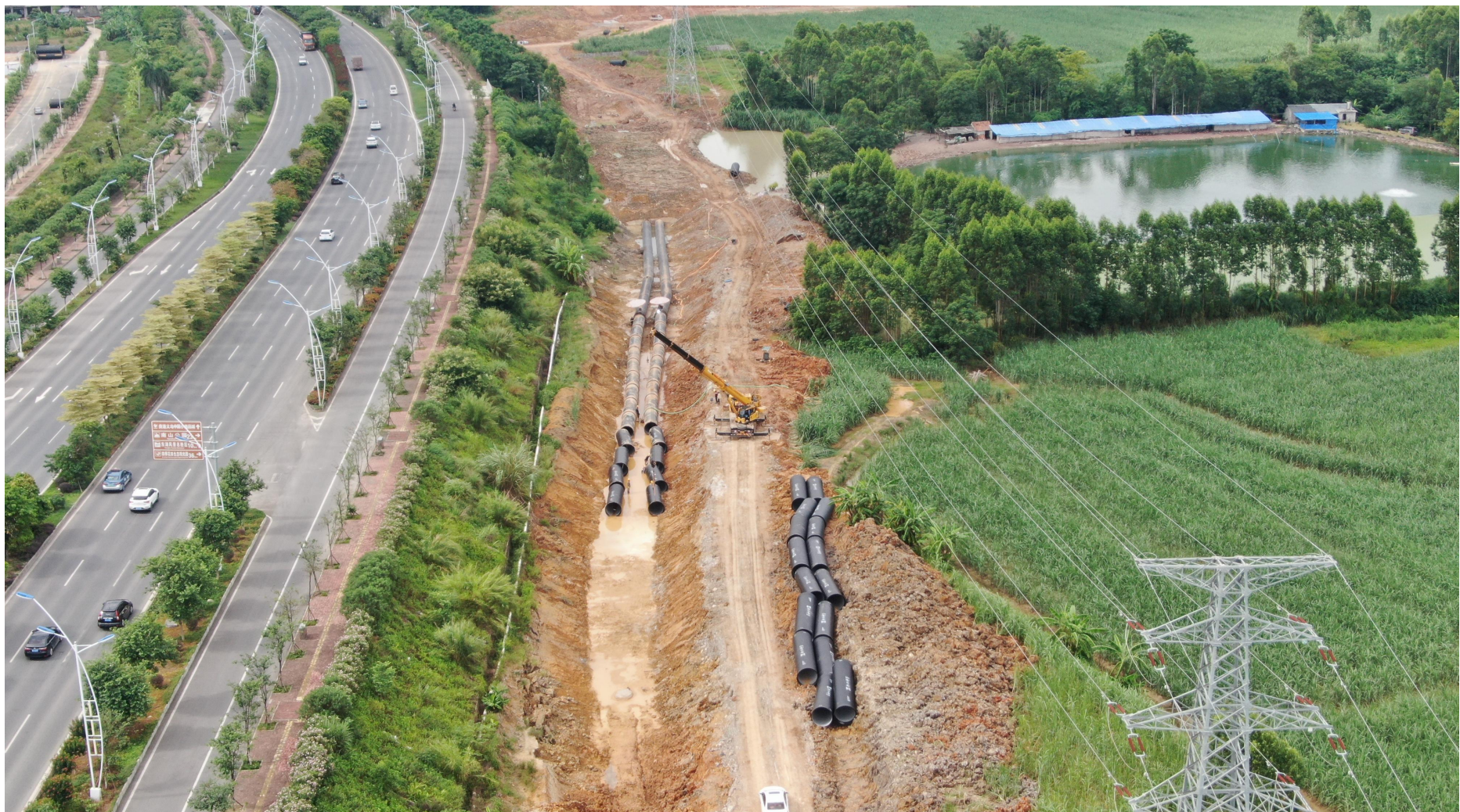
图 3 管网工程区已开挖区域现状
