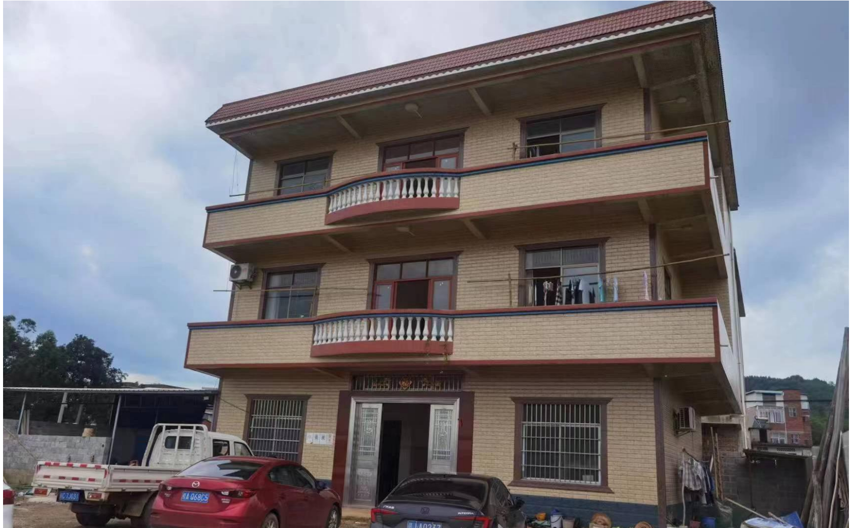
图 7 施工生活区租用房屋现状图
