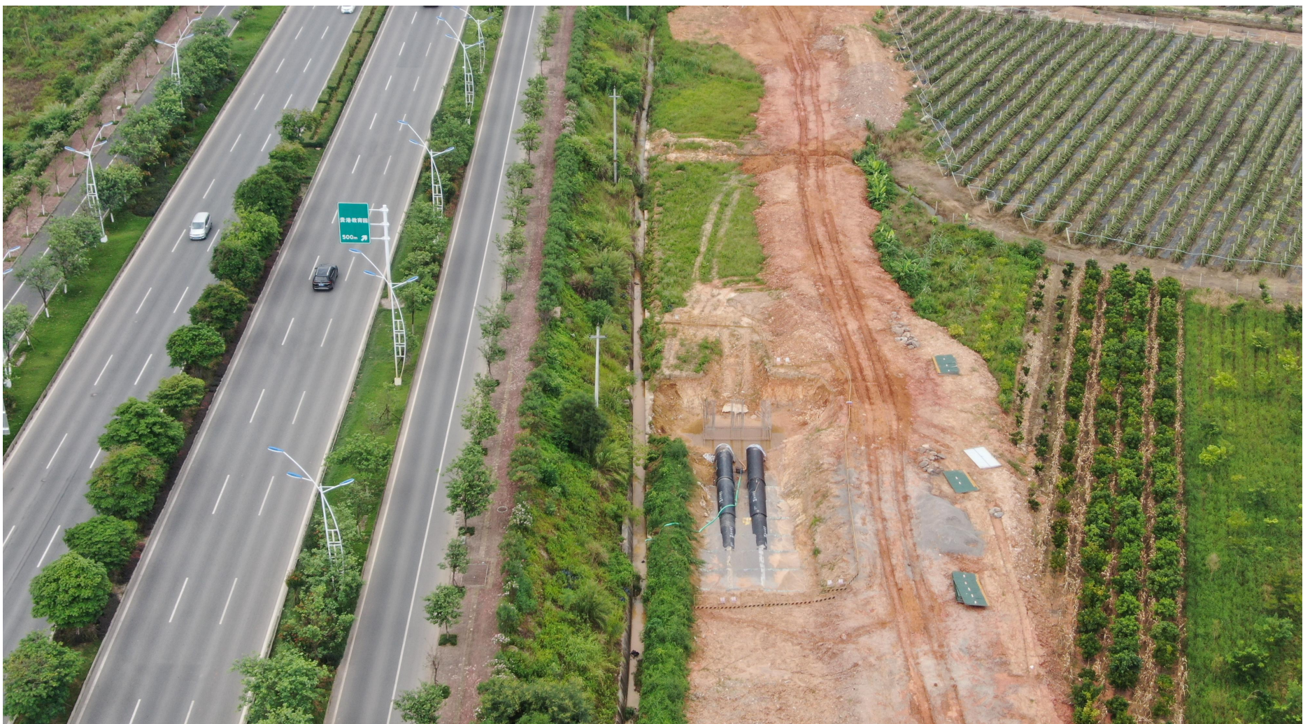
图 2 管网工程区回填现状图
