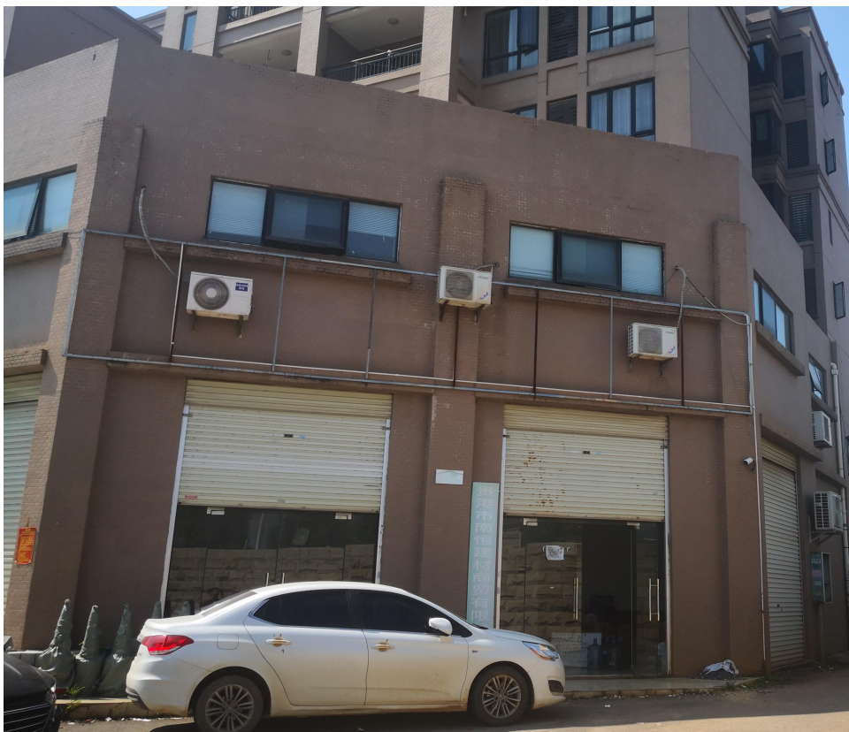
图 8 施工生活区租用房屋现状图
