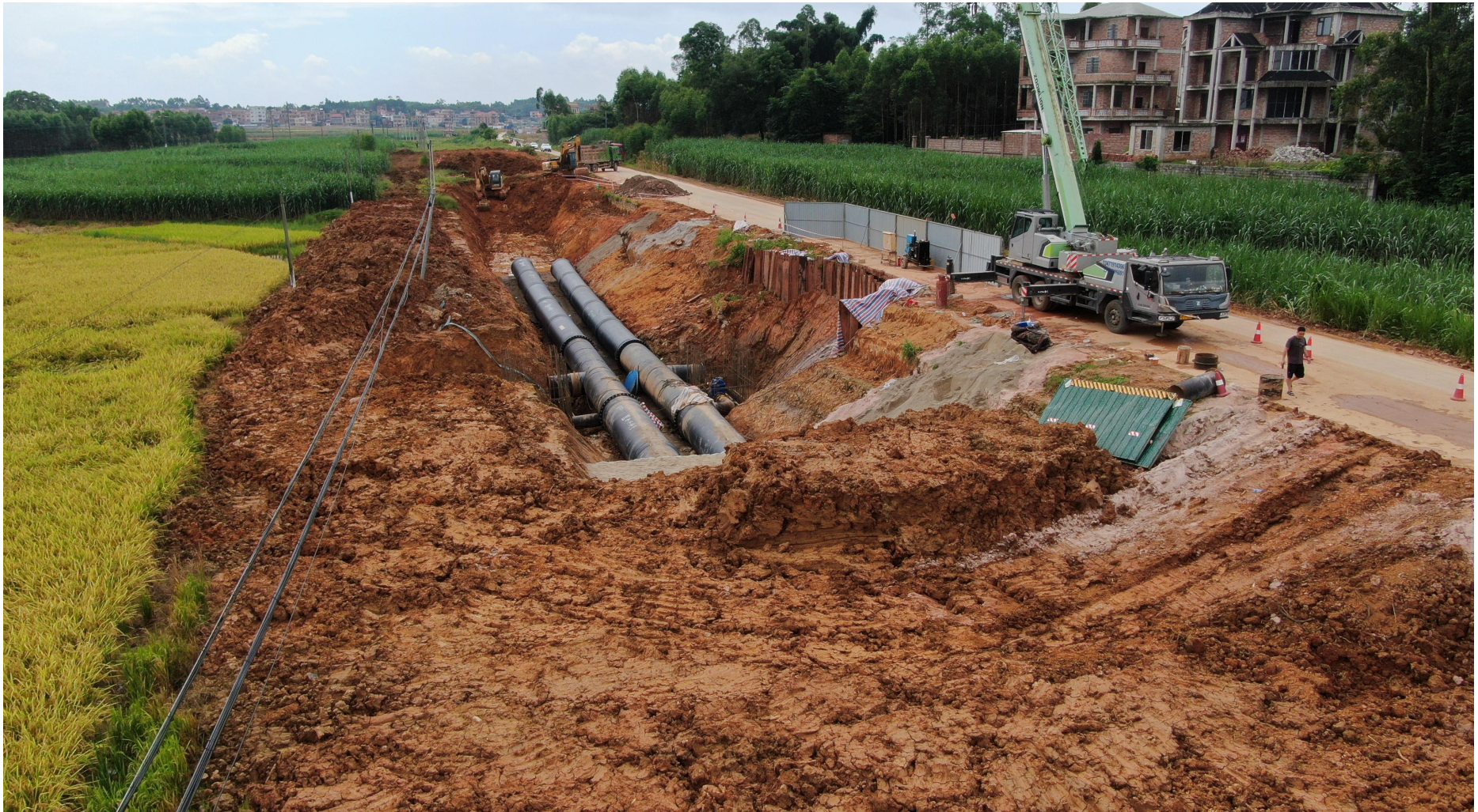
图 6 管网工程区开挖及沟槽两侧堆土现状
