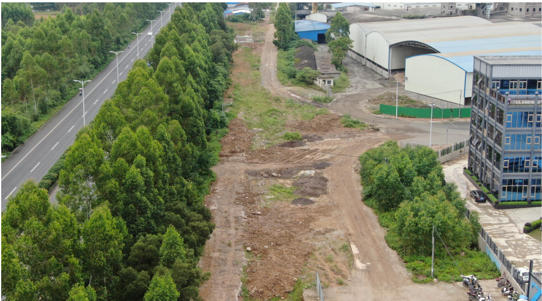
图 5 管网工程区管网施工完成现状图
