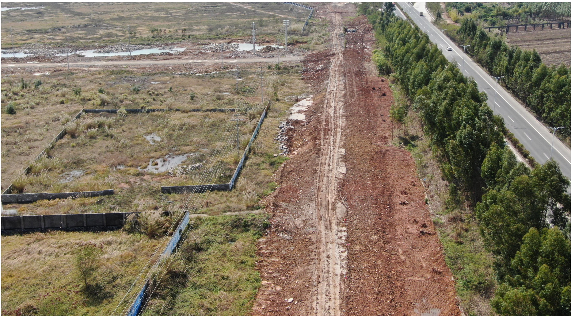
图 2 管网工程区回填现状图
