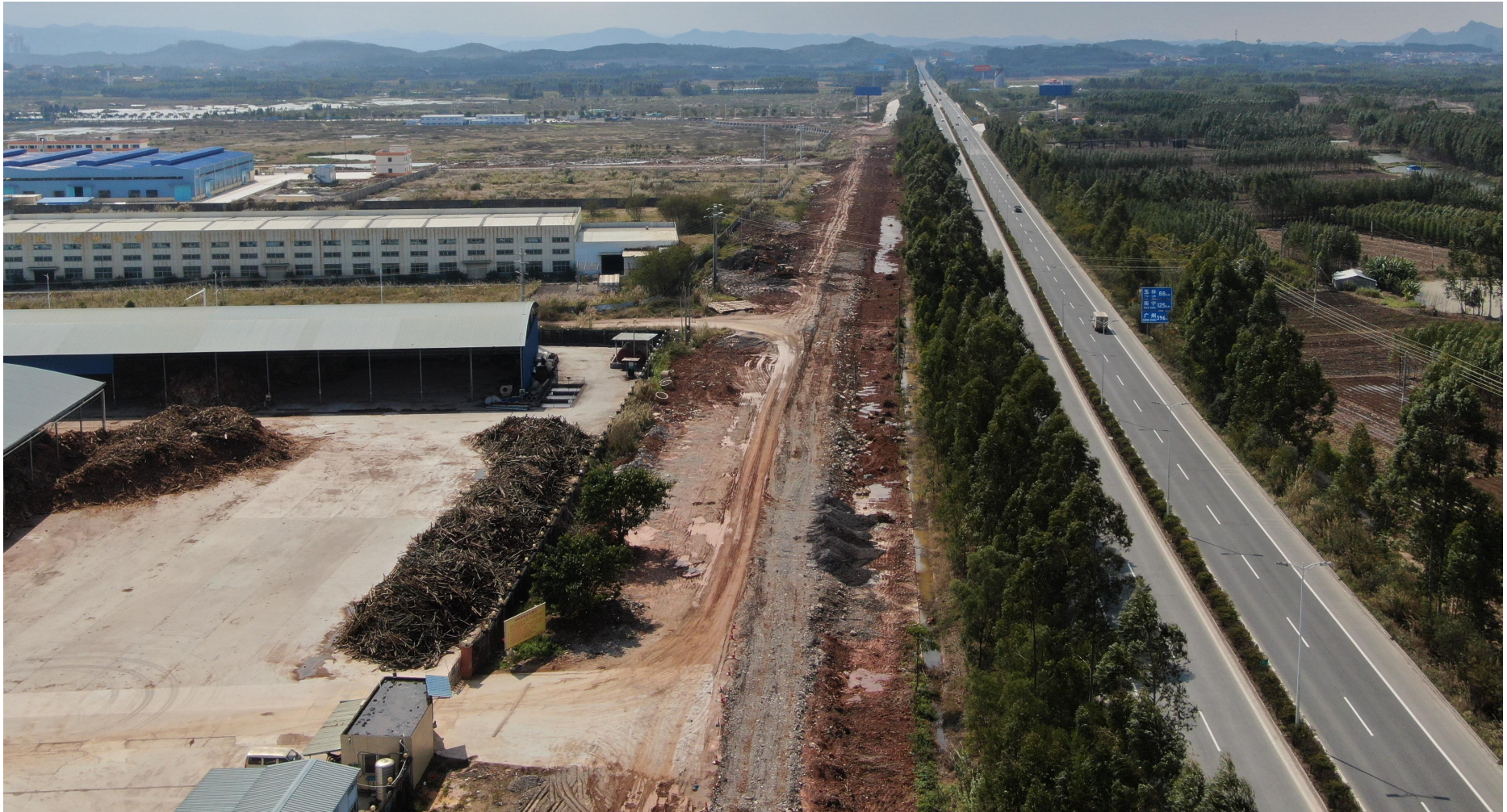
图 1 管网工程区施工现状图
