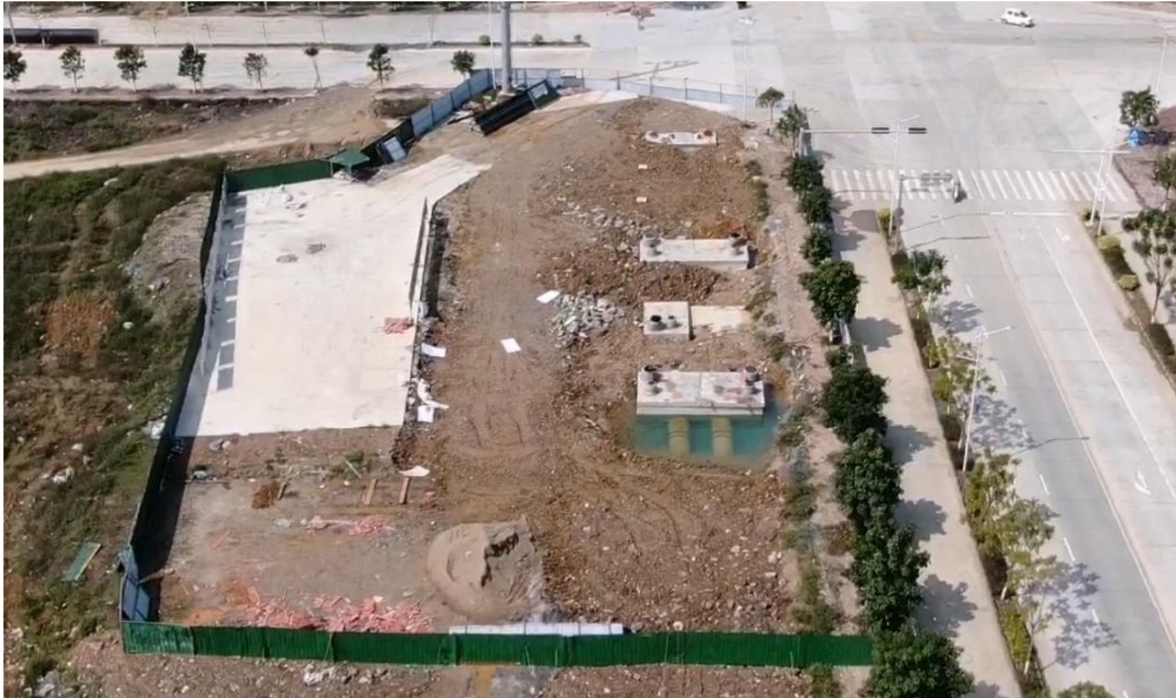
图 6 施工生产区暂停使用现状图
