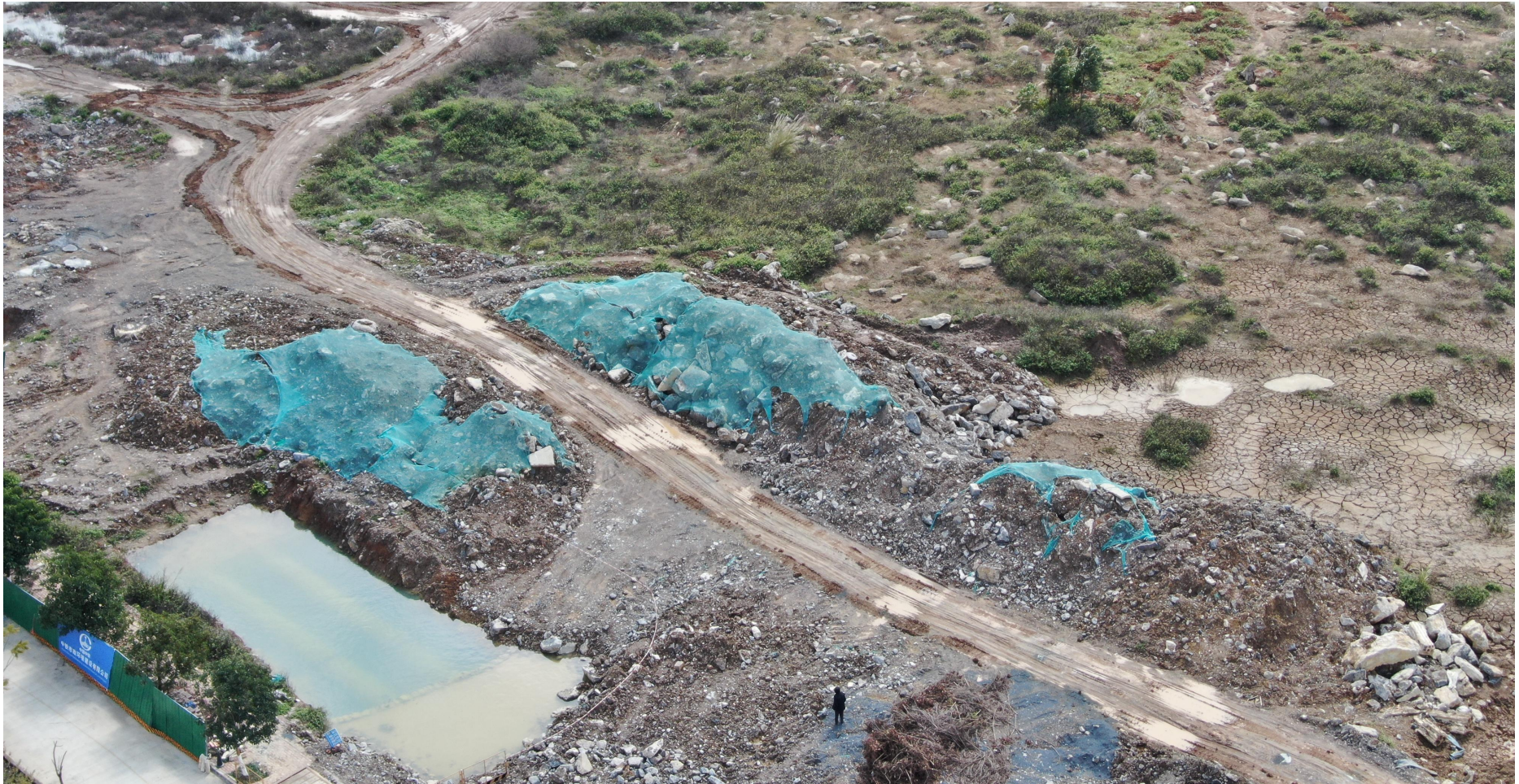
图 3 管网工程区临时苫盖现状图
