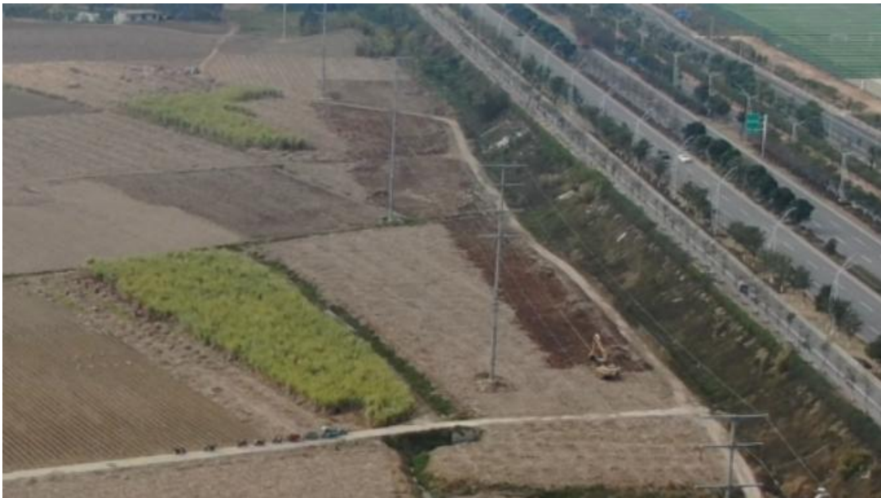
图 5 管网工程区表土剥离现状图
