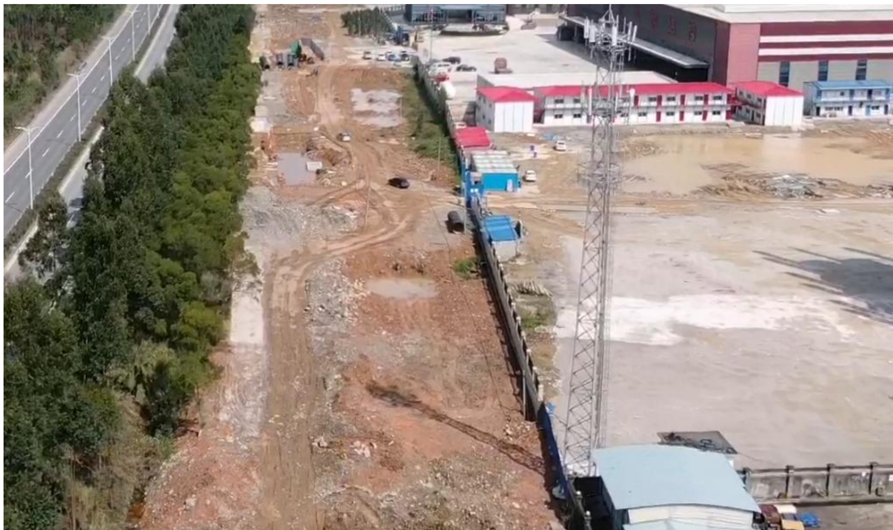
图 7 管网工程区管网施工完成现状图
