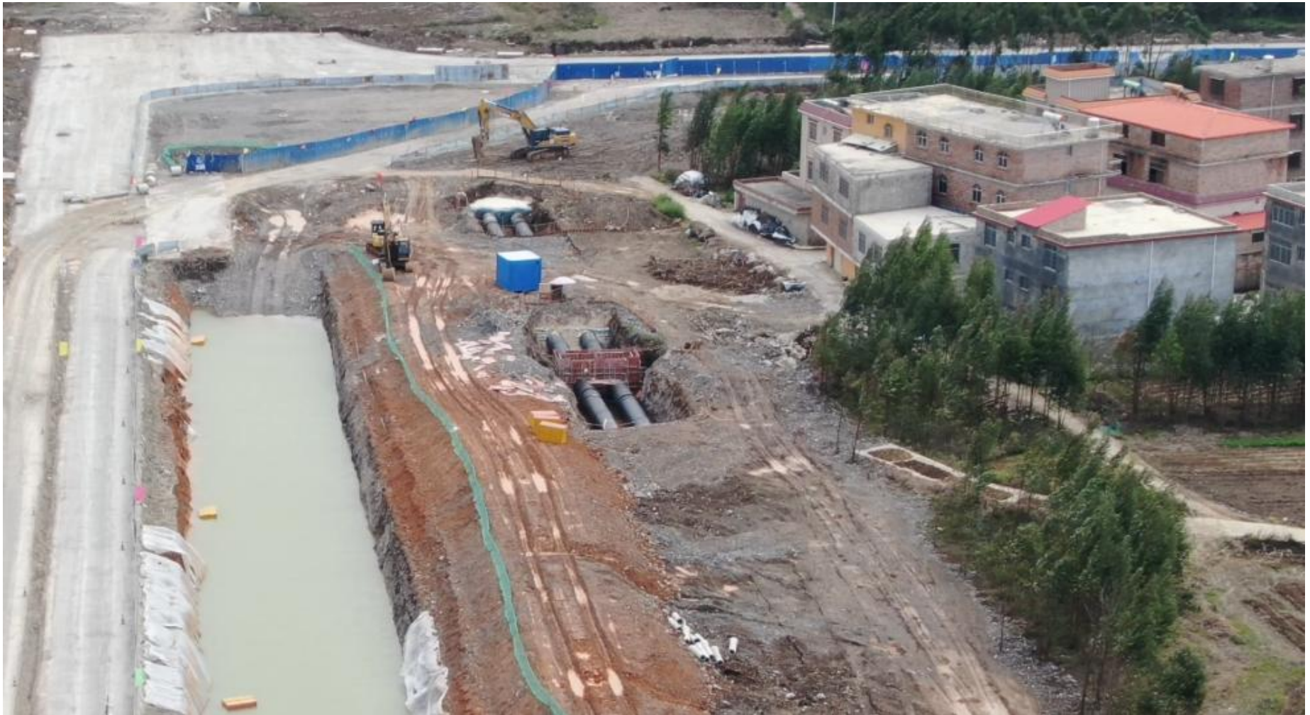
图 4 管网工程区已开挖区域现状
