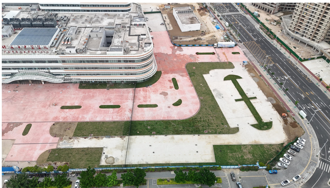
项目已实施草皮铺种区域现状 (2025 年 4 月 10 日拍摄)
