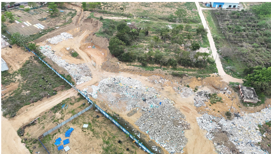
项目区临时堆土区现状(2025 年 4 月 10 日拍摄)
