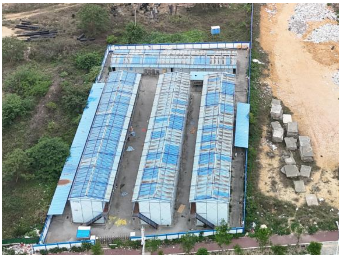
2号施工生产生活区现状(2025年4月10日拍摄)
