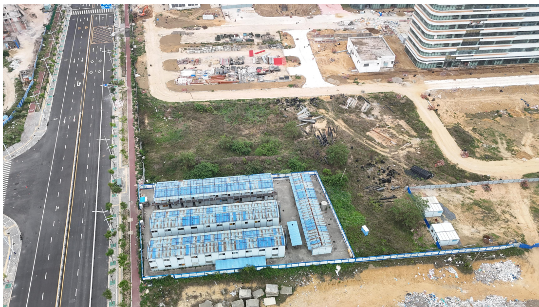
项目东北部现状 (2025 年 4 月 10 日拍摄)
