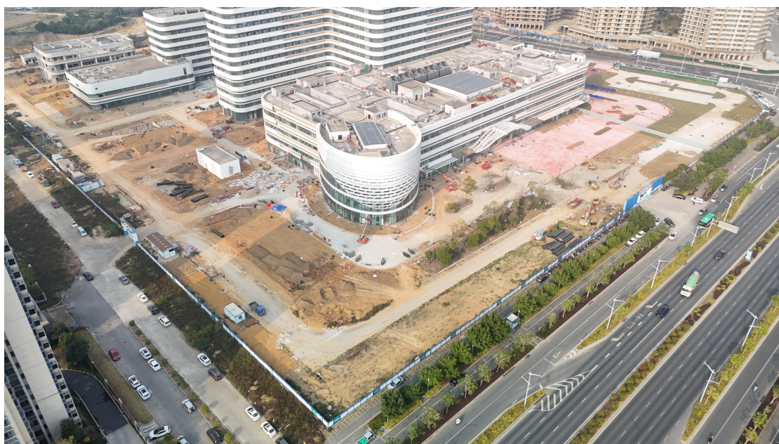
项目现状全景图 (2025 年 4 月 10 日拍摄)
