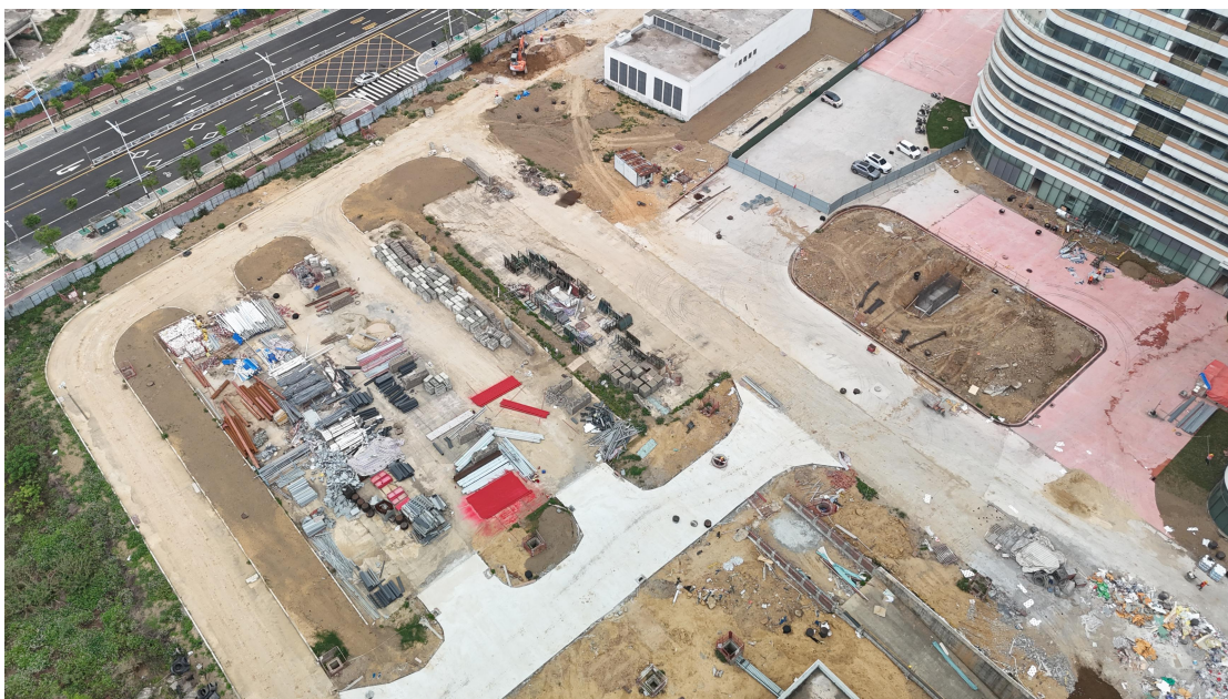
项目区表土回覆区域现状 (2025 年 4 月 10 日拍摄)
