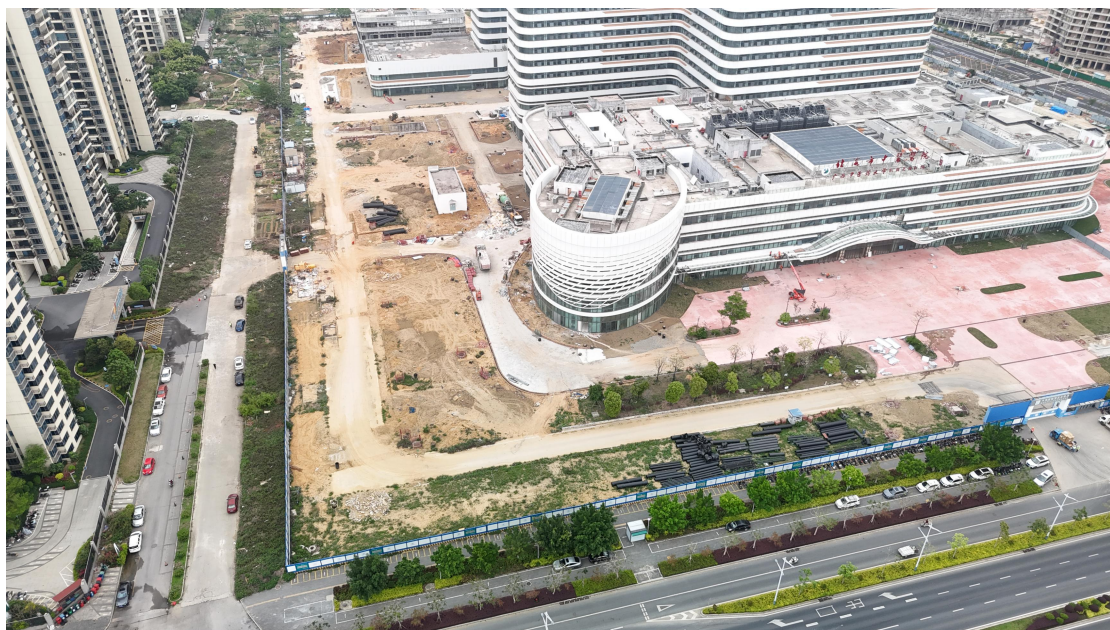
项目西南部现状 (2025 年 4 月 10 日拍摄)
