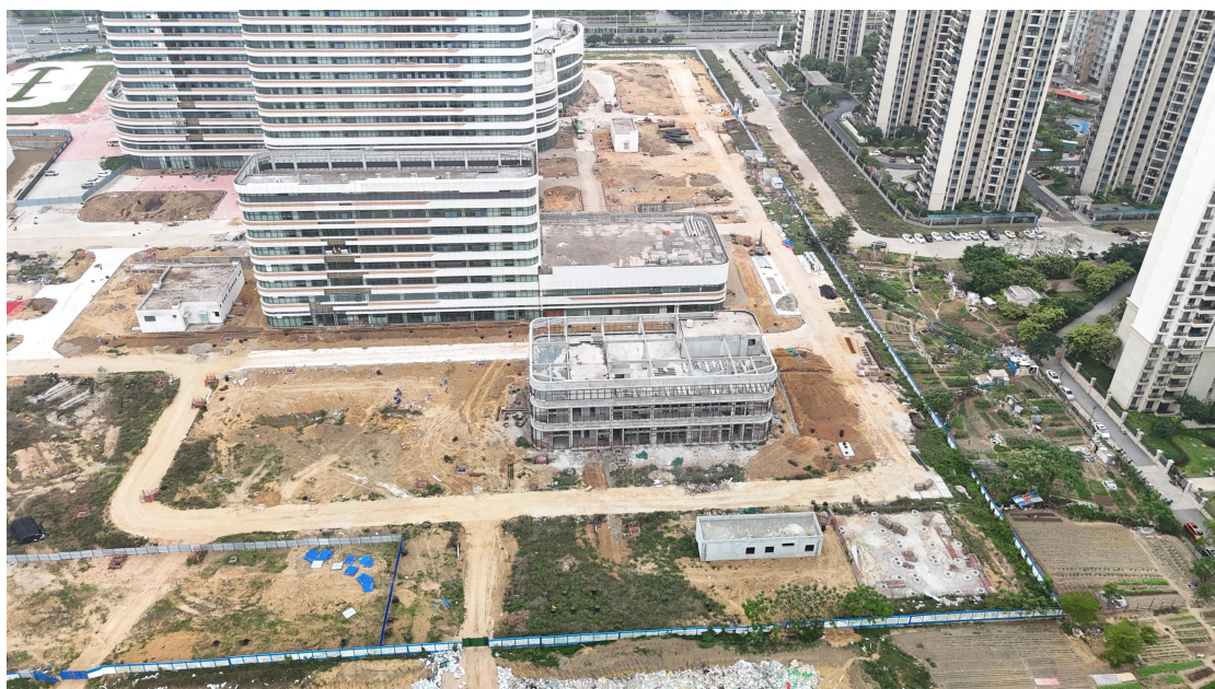
项目西北部现状 (2025 年 4 月 10 日拍摄)
