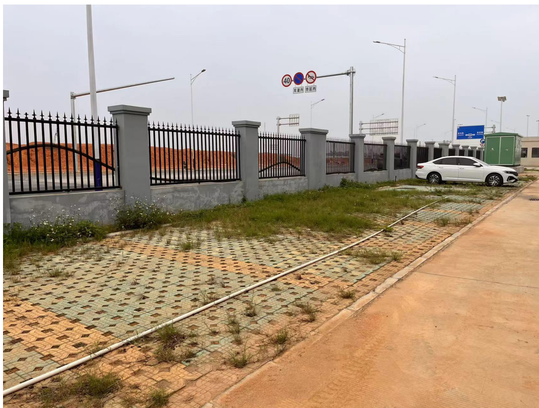
项目区西部现状（拍摄时间：2025 年 3 月）
