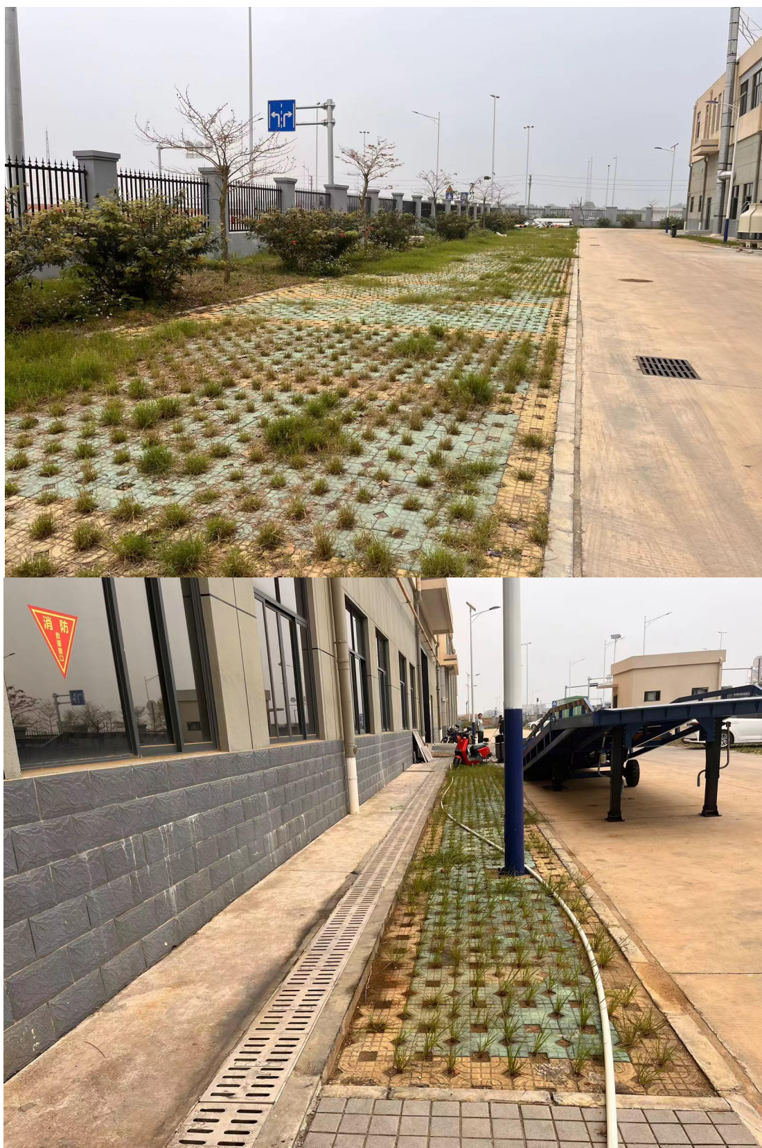
项目区植草砖现状（拍摄时间：2025 年 3 月）
