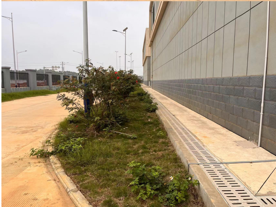
项目区排水沟、广场砖铺设、绿化现状（拍摄时间：2025 年 3 月）
