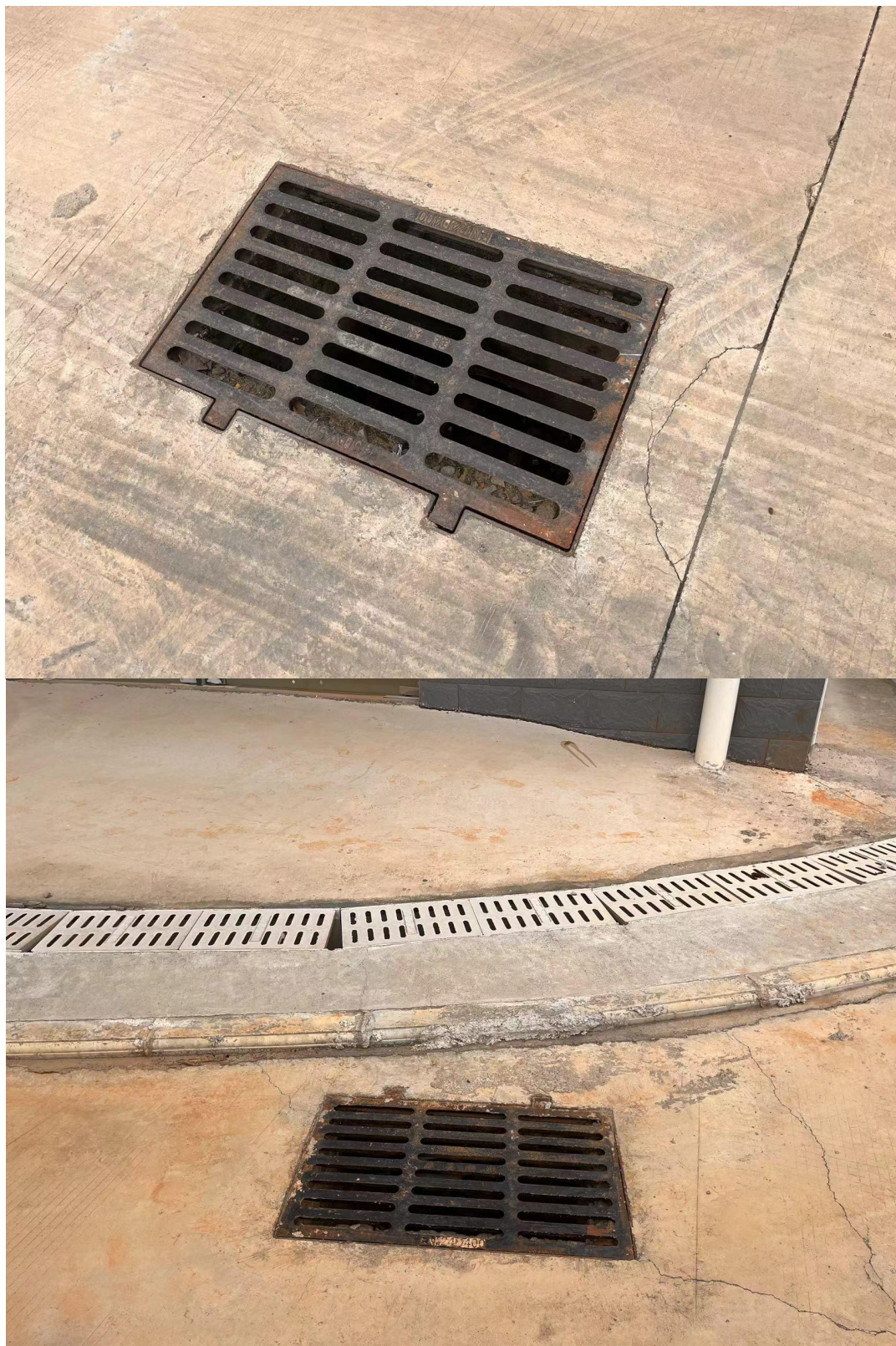
项目区雨水口、排水沟现状（拍摄时间：2025 年 3 月）
