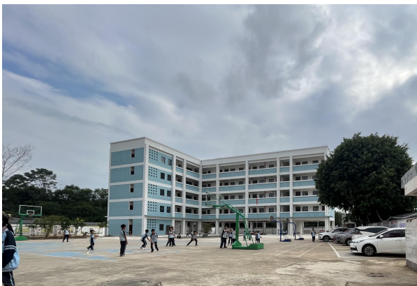
现状新建教学楼（2024 年 10 月）
